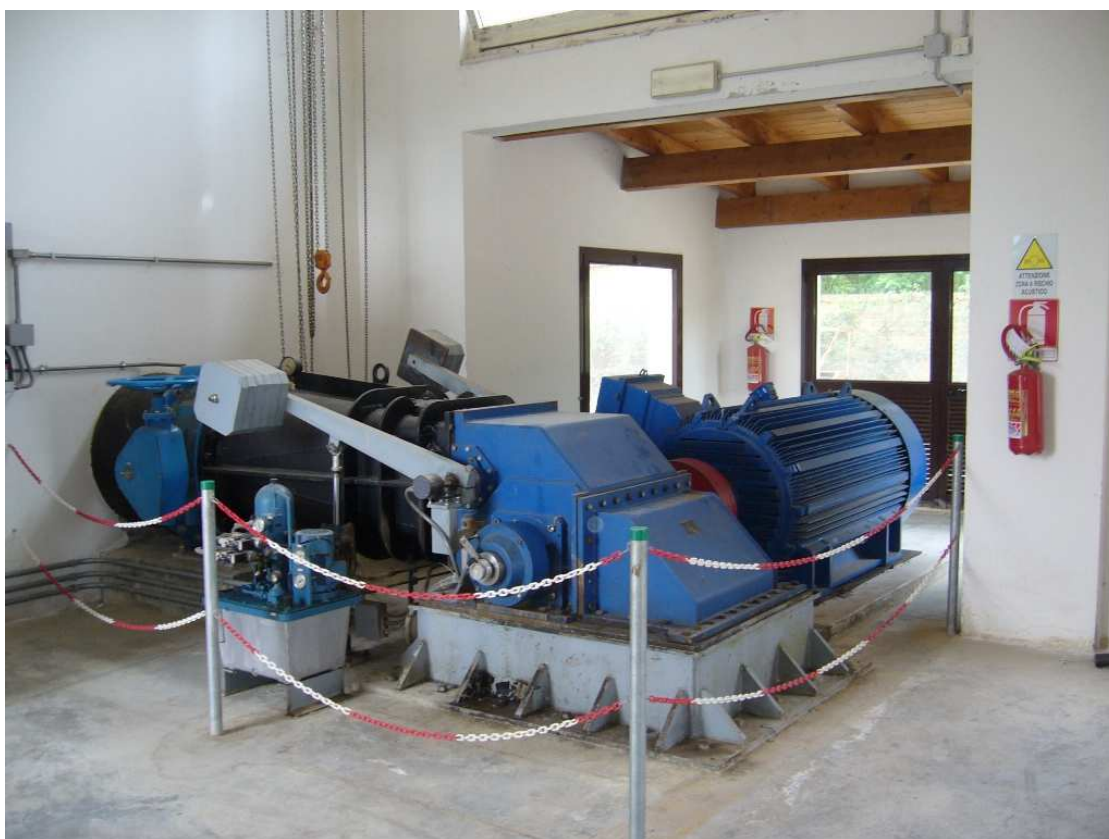
Figura 5.3 – Esempio di installazione di una turbina tipo Banki-Ossberger.
