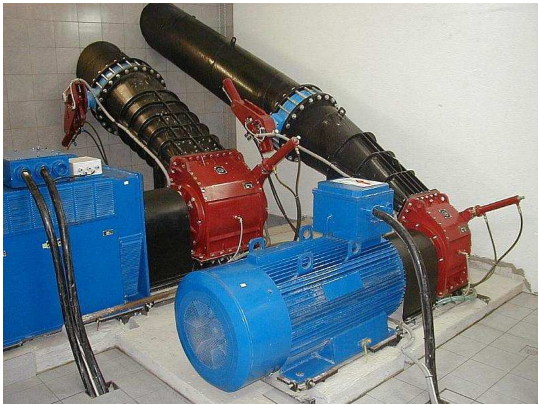
Figura 5.4 – Esempio di installazione di una turbina tipo Banki-Ossberger.
