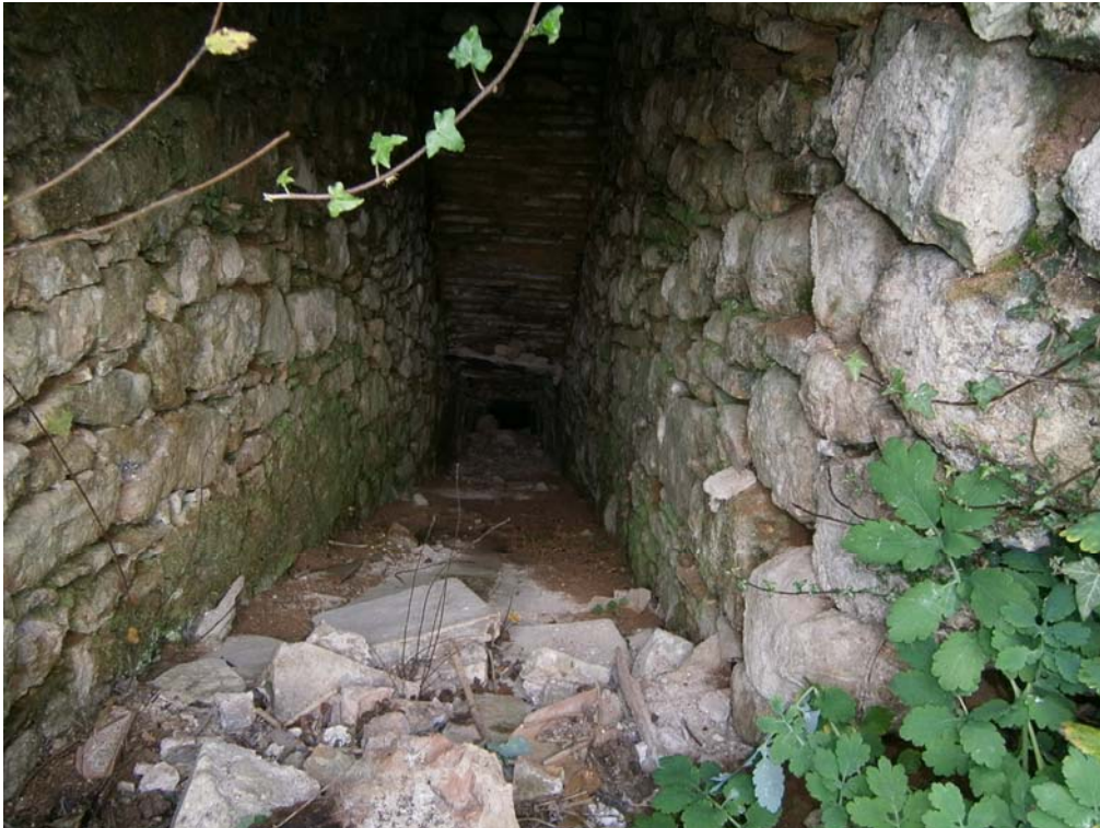
FOTO N° 11 Particolare dei canali di ingresso dell'acqua alla cartiera
