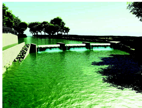
Rendering del progetto con vista da valle verso monte (dettaglio della scala di risalita dei pesci e dello sbarramento ad acqua fluente)
