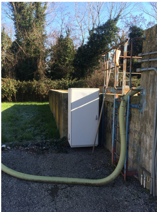
Figura 3: Posizionamento pompa di dosaggio ipoclorito di sodio – Bacino di clorazione
