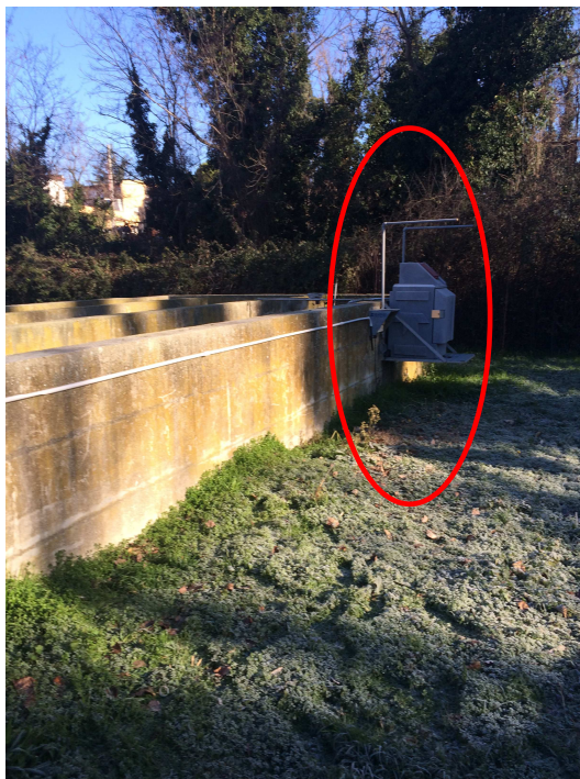
Figura 6: Campionatore automatico delle portate in uscita dall'impianto di depurazione
