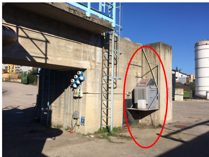
Figura 5: Campionatore automatico portate in ingresso al trattamento biologico.
