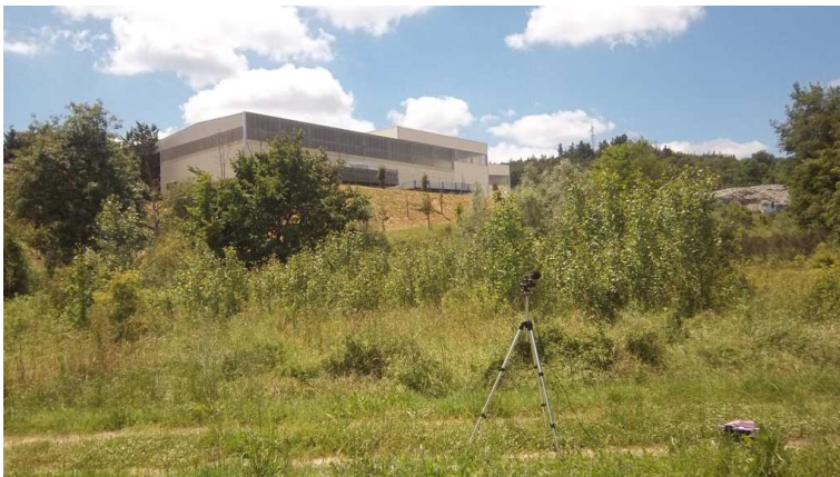
punto di misura E6, vista in direzione ovest (verso gli impianti)
