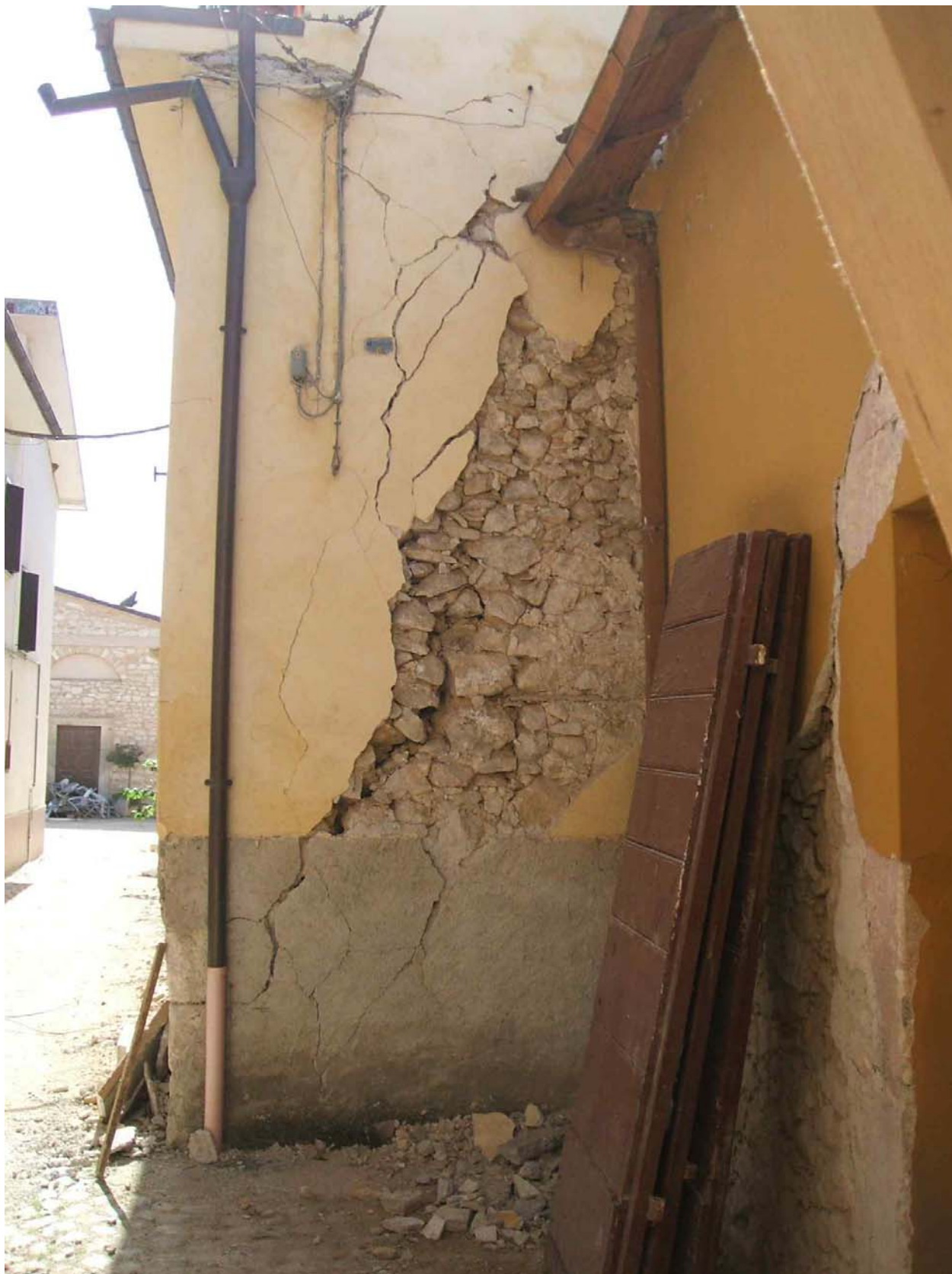
2 - Espulsione dello spigolo, principalmente verso la strada ma con una componente anche verso l'osservatore della foto.
