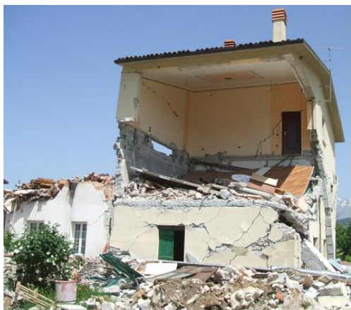
Figura 2-33: Edificio 4903444, prima e dopo il sisma. Edificio nuovo in laterizio affiancato ad un edificio esistente in blocchi e pietra- me con sopraelevazione. La complessità della situazione strutturale, unitamen- te alla insufficiente ampiezza del giunto sismico fra i due corpi, ha portato ad un fenomeno di martellamen- to. Nelle fotografie si confronta la situazione ante sisma con quella attuale.
