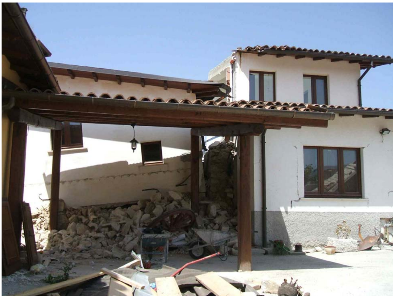
28 - Telaio in c.a. a destra: lesioni sulla tamponatura per taglio; edificio in muratura a sinistra: crollo della parete in pietrame e traslazione rigida del piano sopra in blocchi. La direzione della traslazione, congruente con le lesioni a taglio della tamponatura del telaio in c.a., potrebbe indicare la direzione del sisma.
