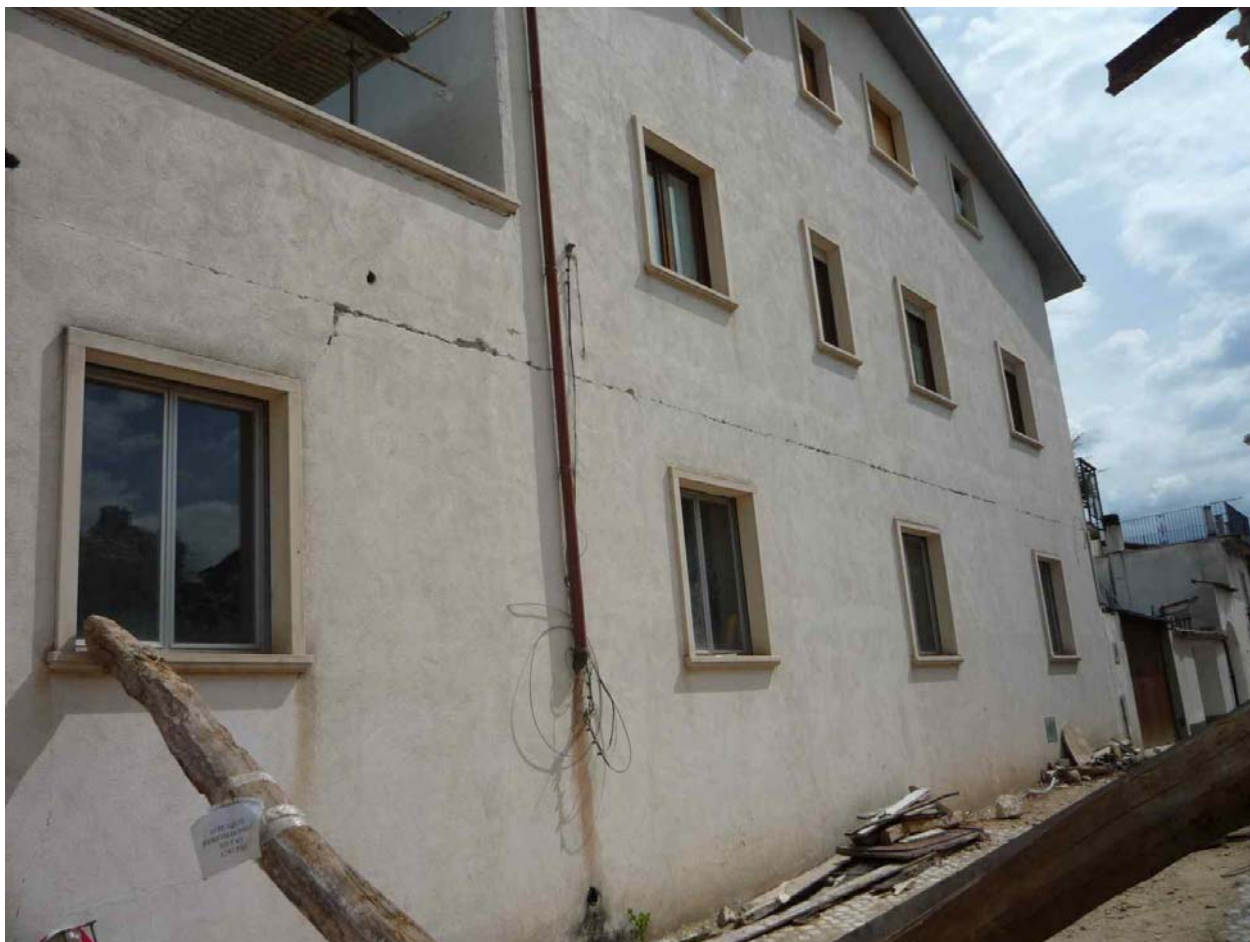
15 - Lieve distacco di tamponatura dalla trave in c.a. La tamponatura tende ad andare fuori piano. Si tratta di tamponatura confinata superiormente da uno sbalzo che parte dalla trave del telaio in c.a. arretrato rispetto al filo esterno dell'edificio. La tamponatura al piano terra solitamente è in pietrame; ai piani superiori invece è quasi sempre in laterizi forati.
