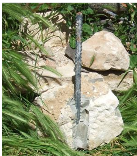
Figura 2-30: Aggregato 4902634 (chiesa). Dettaglio di intervento con perforazioni armate sul campanile.
