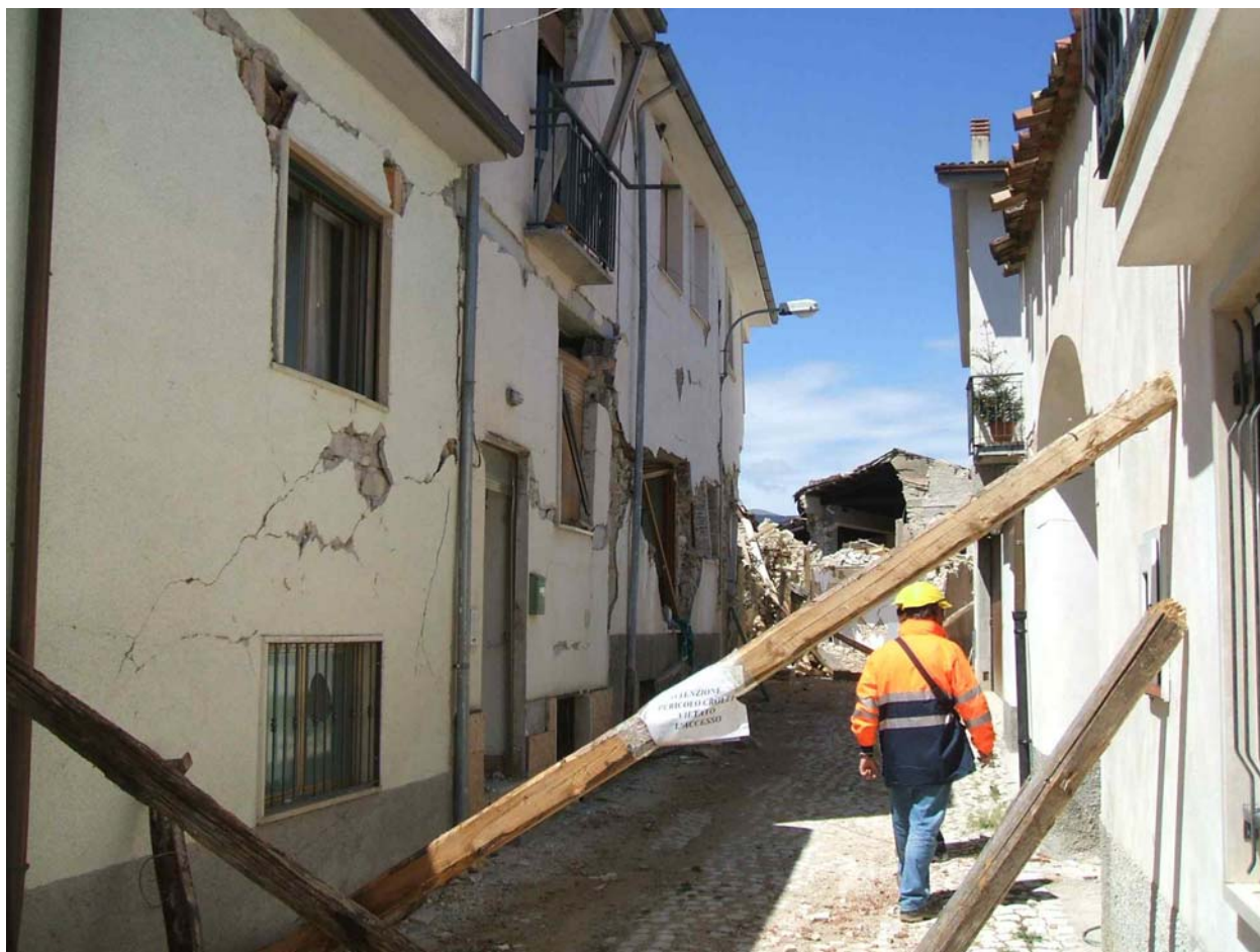
12 - Lesioni a taglio (nel piano) sugli edifici a sinistra (via Ludovici) sia sulle murature sia sulle tamponature del telaio in c.a.
