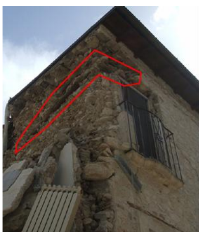
Figura 4902682-13: Antico cordolo in legno nella U.S. 11. La parte a sinistra, crollata, è la U.S. 10. Forse il cordolo in legno, formato da due travi in legno di forma circolare chiodate sull'angolo, ha indebolito la muratura. Si noti anche il capochiave in acciaio al piano inferiore.
