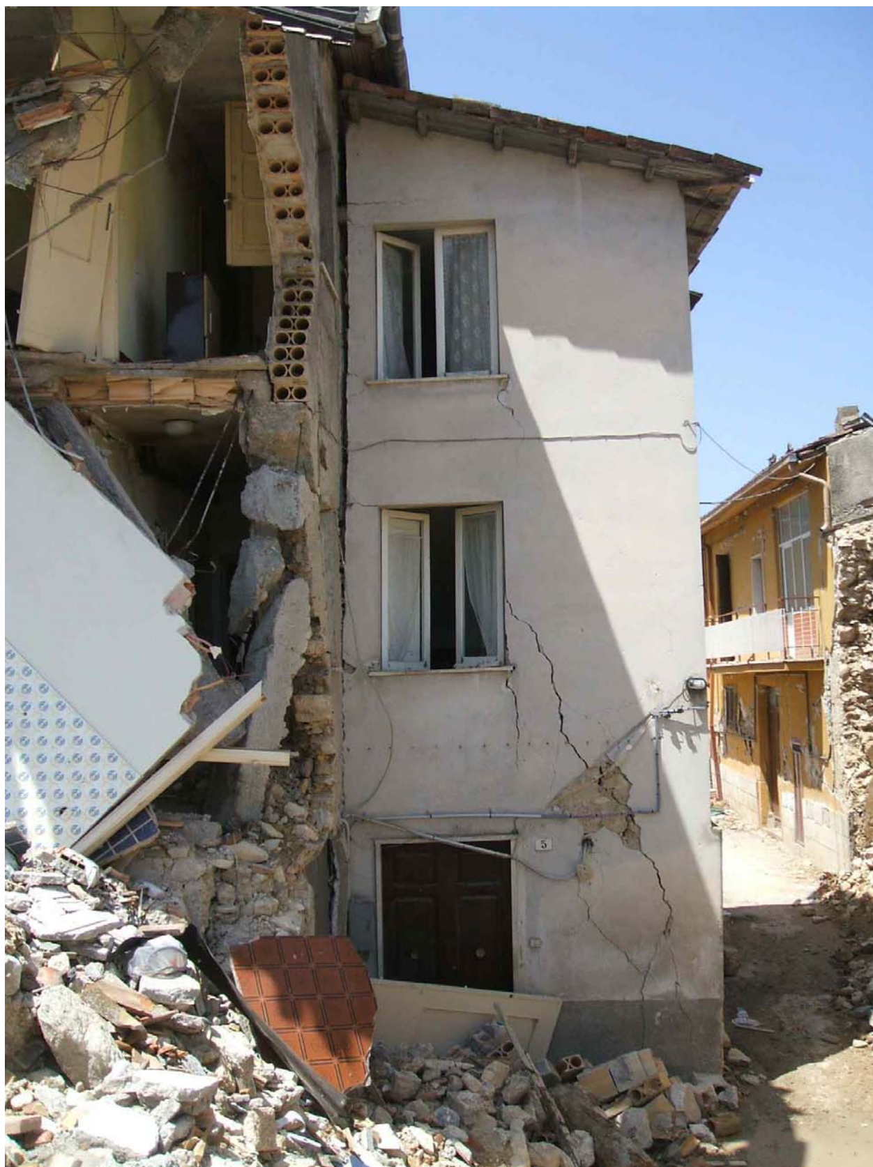
3 - Movimento (rotatorio) in fuori verso la strada dell'intero edificio sulla sinistra. Tale moto è testimoniato sia dal distacco dell'edificio in esame rispetto a quello adiacente sia dallo sfilamento del cordolo (non chiuso) sopra l'ultima finestra sia dalle lesioni di scorrimento della parte in basso a destra dell'edificio.
