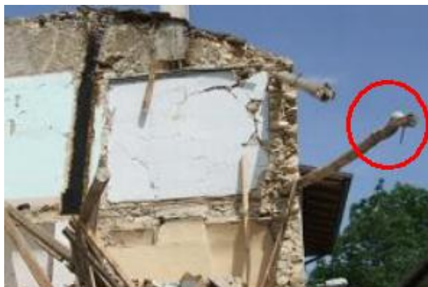
Figura 2-20: Dettaglio della chiodatura d'angolo di un cordolo in legno spezzato.
