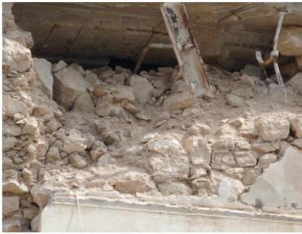
Figura 4902745-11: U.S. 1: copertura in legno con cordolo in c.a. Il tirante in ferro era posizionato ad un livello inferiore rispetto alla copertura.
