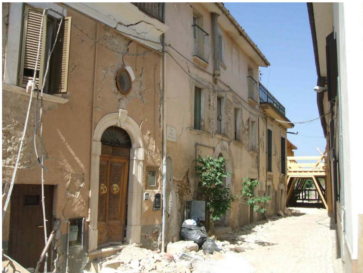
1 - Lesioni per taglio sui maschi murari degli edifici a sinistra. Presenza di martellamento fra edifici adiacenti
