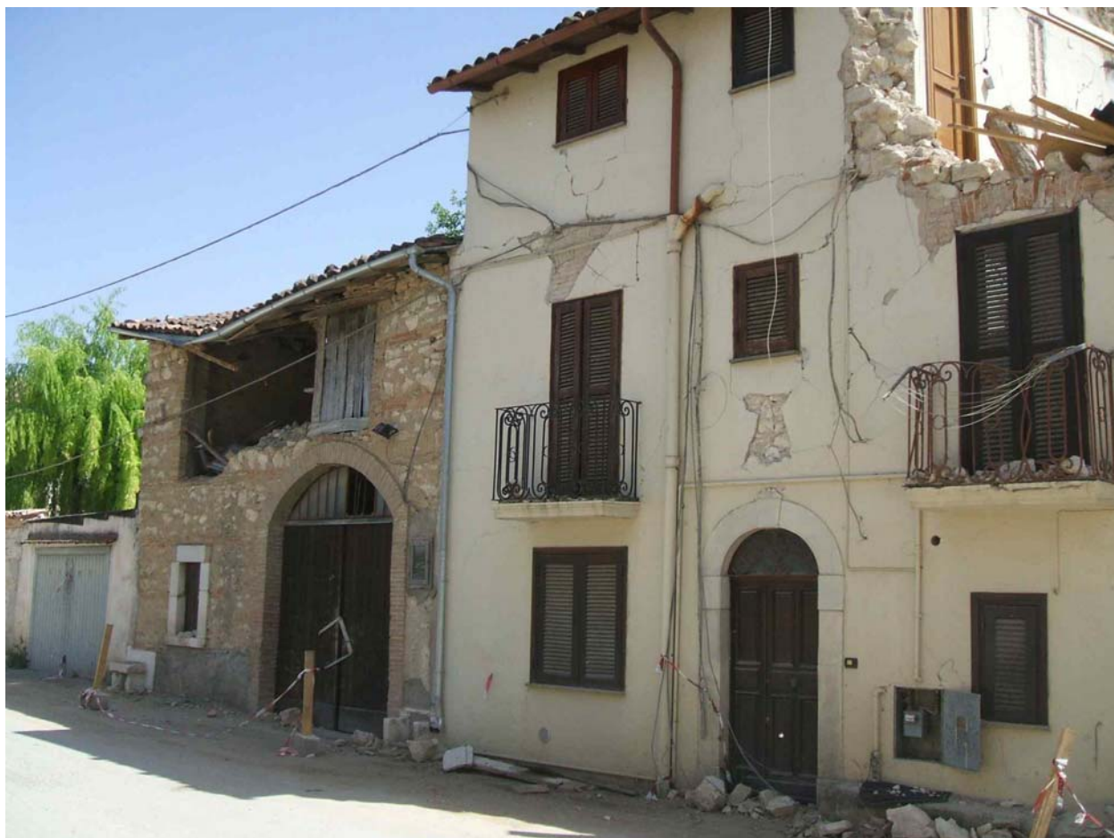
25 - Espulsione fuori piano della parete fra le due finestre al secondo livello della casa a sinistra. Appare improbabile il meccanismo di piano perché le altre pareti non hanno lesioni nel piano.
