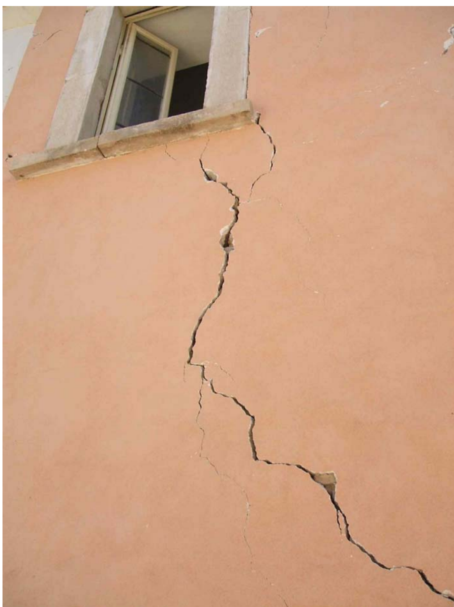
7 - Meccanismo misto con espulsione fuori piano dello spigolo e trascinamento di un cuneo del muro di spina. Dalle tre fotografie si ricostruisce il moto dei macroelementi ed il cinematismo attivato.
