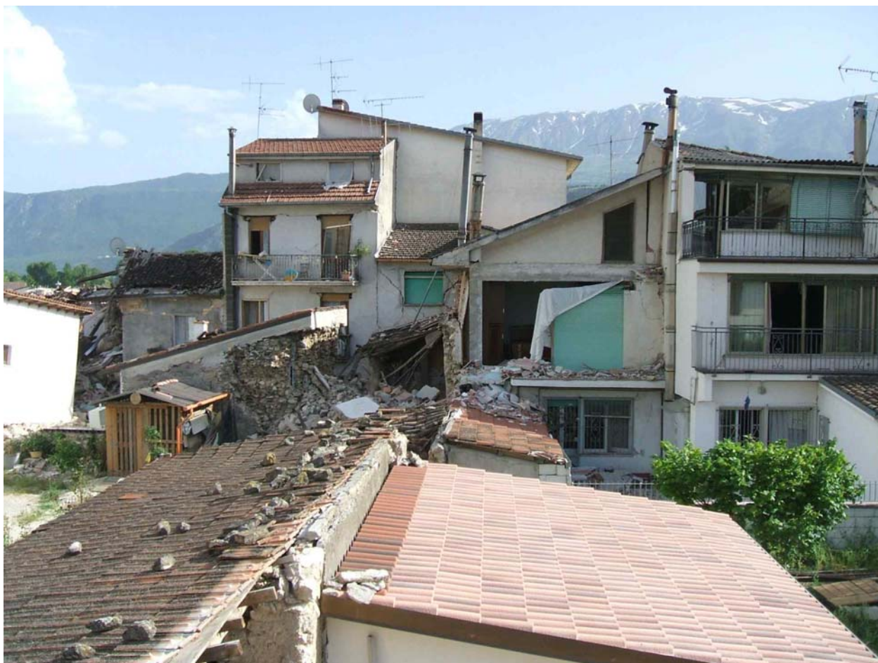
13 - Movimento del telaio di c.a. in primo piano da destra verso sinistra: l'angolo formato dalla trave e dal pilastro del telaio sembra acuto a causa della deformazione dovuta al sisma. Una parete in muratura ribalta fuori piano nella stessa direzione. L'edificio di tre livelli in muratura visibile in secondo piano si muove nella stessa direzione.
