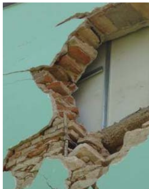
Figura 4902745-23: Dettaglio della superficie di distacco del cuneo murario. Si nota come il cordolo in legno che chiudeva la parte sommitale della muratura prima che questa venisse sopraelevata abbia introdotto un elemento di debolezza nella parete.
