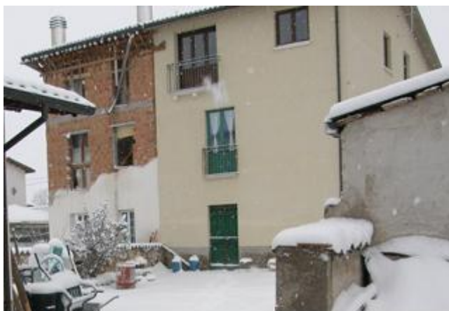
Figura 2-32: Edificio 4902644. Piano terra in pietra- me è crollato trascinandosi dietro, come blocco rigi- do, il primo piano in blocchetti.
