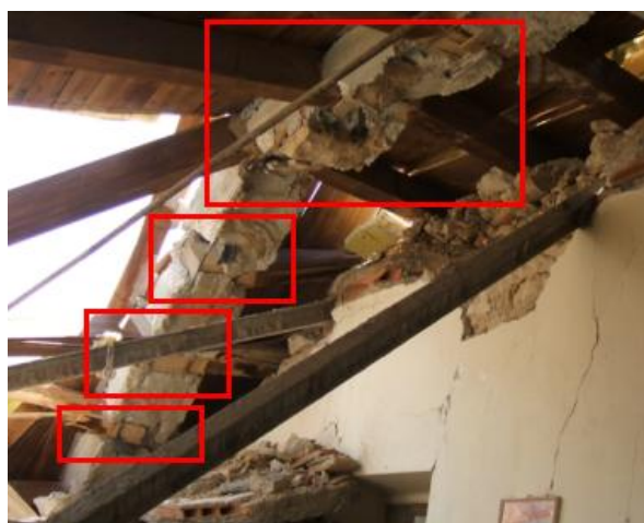
Figura 2-25: Aggregato 4902686. Copertura realizzata nel 2007. Sono cerchiare in rosso le interruzioni del cordolo dovute agli innesti delle travi in legno.
