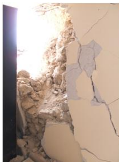
Figura 4902745-19: U.S. 11. Collasso fodera interna della muratura.
