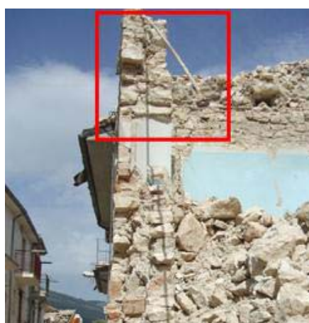
Figura 4902682-14: U.S. 17. Si tratta della cellula di testata della parte a schiera dell'aggregato in esame. La catena in acciaio nel mezzo della parete costituisce un elemento che favorisce la separazione dei due paramenti murari esterno ed interno. Questa catena, probabilmente, risale al periodo di poco successivo al sisma del 1915.
