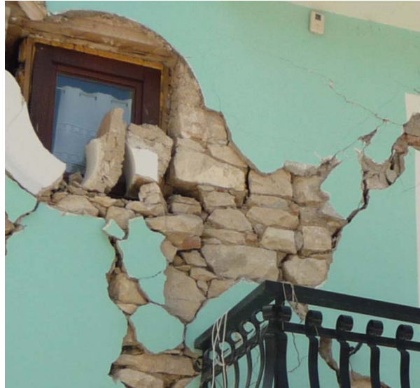
Figura 4902745-9: Pareti delle U.S. 14 e 15 prospettanti su via dei Calzolari (secondo piano). Sezione muraria appartenente all'U.S. 14 e paramento murario esterno dell'U.S. 15. Le due murature delle due U.S. si possono ritenere simili per tipologia.
