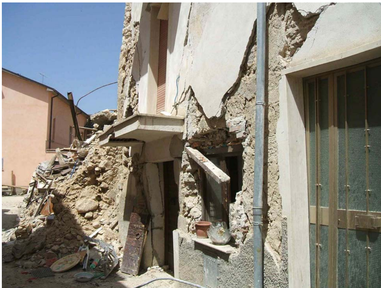
27 - Forte dislocazione, congruente con lo spigolo fuoripiombo della foto 26. Si noti la spalletta sinistra della porta a piano terra.
