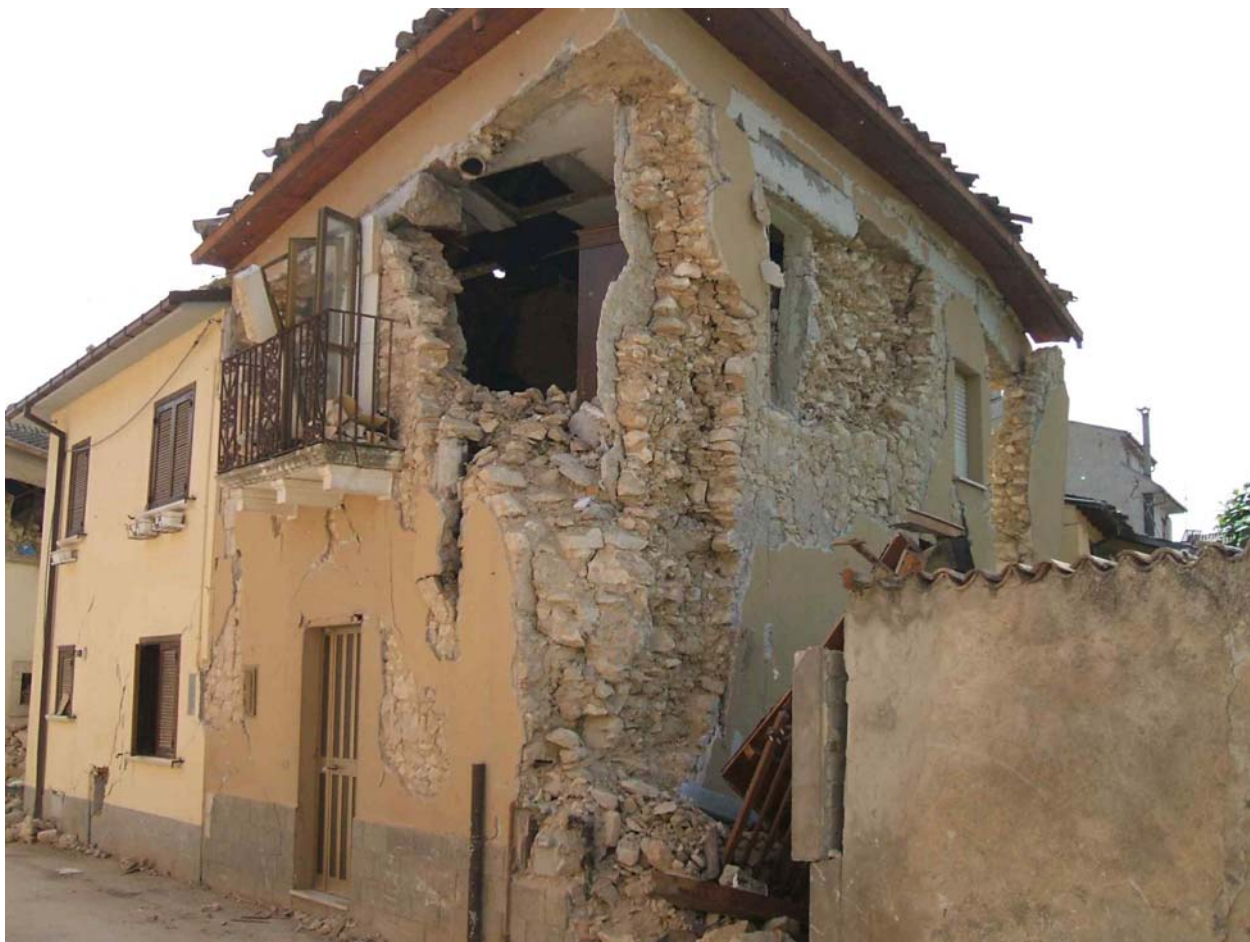
22 - Meccanismi fuori piano sull'edificio di foto 21, questa volta interessa osservare la parete ortogonale a quella di foto 21. Espulsione fuori del piano del paramento esterno e altri meccanismi fuori piano.
