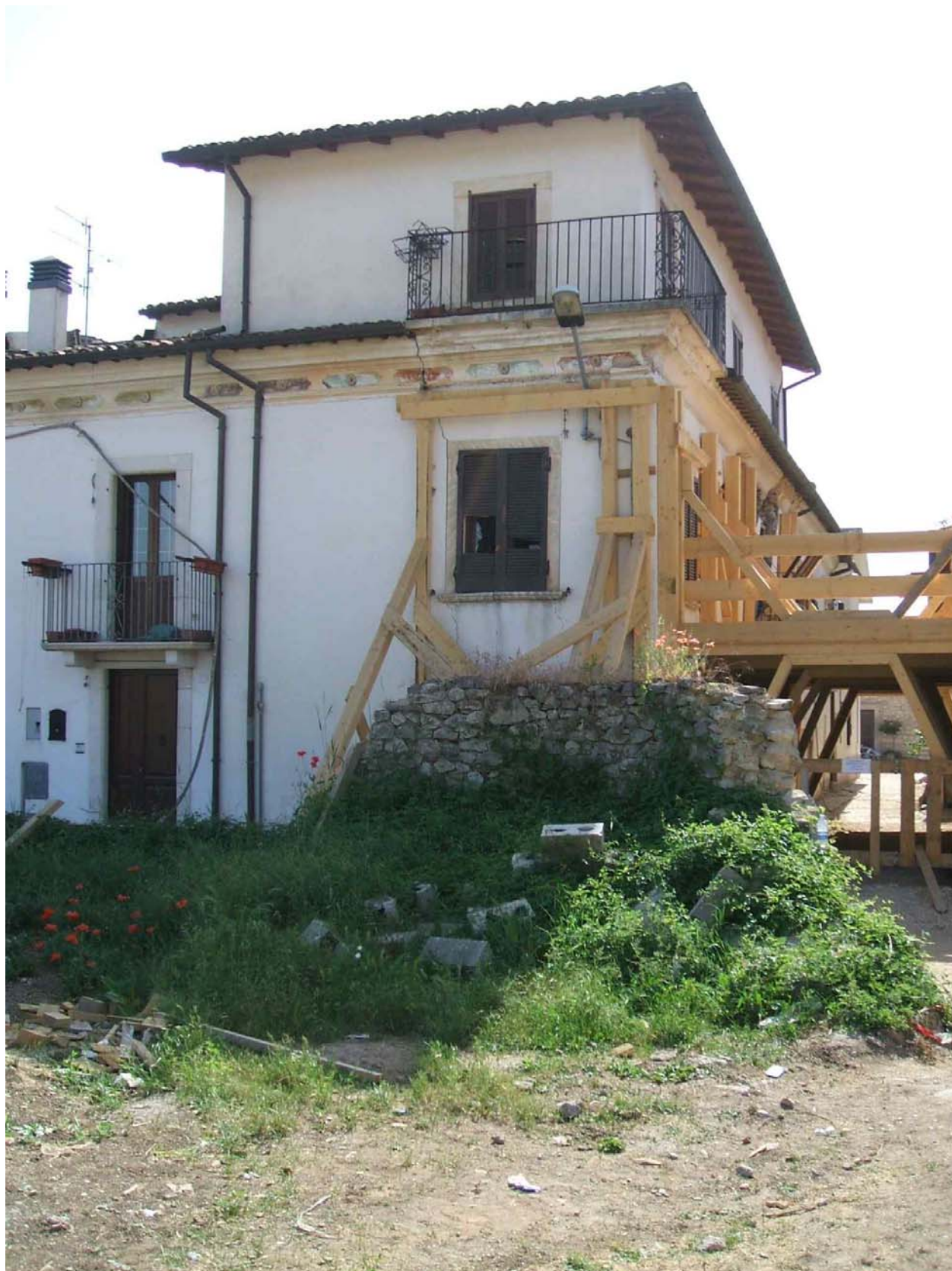
5 - Lesioni nel piano dell'edificio di sinistra sopra l'architrave e sul fregio al livello del primo solaio. Sulle pareti di via Massale, seminascondi dalla puntellatura, si notano ribaltamenti ed espulsioni fuori piano localizzate alle zone murarie sopra le finestre dell'edificio di sinistra
