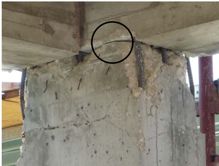
Figura 4902689-4: Dettaglio che evidenzia la netta soluzione di continuità tra i getti.
