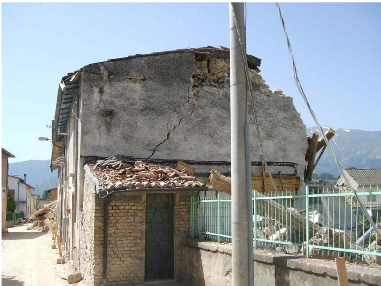
11 - Scorrimento verso destra e verso l'osservatore della foto della parte superiore dell'annesso ad un piano. Si noti, sull'annesso, la lesione di scorrimento dei mattoni presente sul maschio murario di sinistra. Lesione di scorrimento (nel piano) sulla parete di testata dell'aggregato e principio di ribaltamento fuori piano della parete laterale sinistra.
