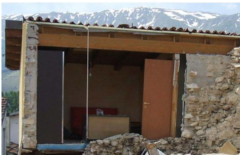
Figura 4902745-18: U.S. 11. Parte superiore ricostruita in adiacenza alla muratura in pietrame dell'U.S. 10 crollato.
