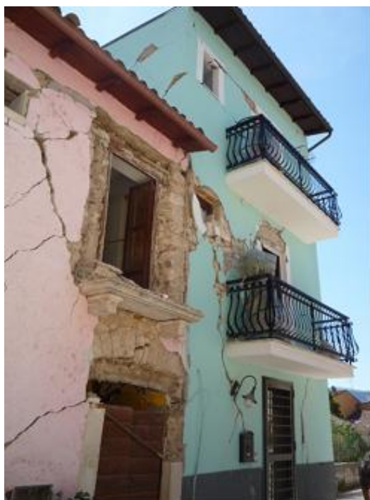
Figura 4902745-24: U.S. 15, facciata Nord. L'U.S. bassa adiacente è la 14. Si noti il movimento complessivo della facciata verso Ovest (destra in foto) con i conseguenti meccanismi di tipo flessionale sugli snelli maschi murari di base e di tipo "taglio" sul pannello murario al secondo piano, più tozzo. Il cinematisma di collasso ipotizzato è congruente con le lesioni di scorrimento della copertura.
