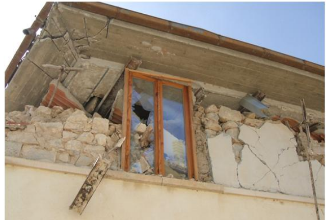
Figura 4902745-14: U.S. 1: dettaglio dell'ancoraggio carente delle armature del cordolo in corrispondenza dell'angolo. I ferri della porzione a sinistra non sono stati piegati nella parte destra del cordolo.
