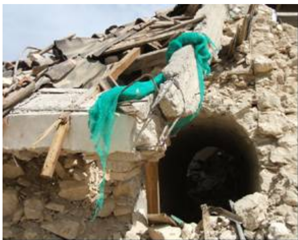
Figura 4902682-9: Cordolo di copertura dell'U.S. 3. Si notino i travetti in legno che entrano nel cordolo e la volta a botte che conduce al cortile interno.
