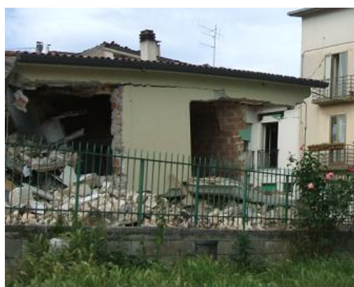
Figura 2-31: Edificio 4902687 con ultimo livello sopraelevato e due piani inferiori in pietrame consolidati con intonaco armato. La disgregazione della muratura dei due piani sottostanti ha causato il collasso dell'edificio.
