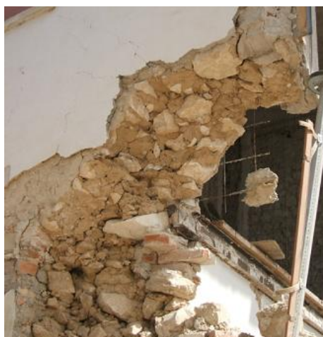
Figura 2-28: Aggregato 4902683. Intonaco armato su muratura di qualità non adeguata.
