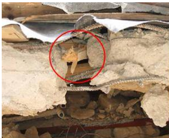
Figura 2-18: Ammorsamento fra un travetto ed il cordolo in c.a: interruzione di sezione del cordolo.
