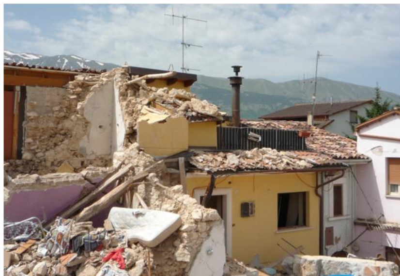
Figura 4902745-18: U.S. 11. Parte superiore ricostruita in adiacenza alla muratura in pietrame dell'U.S. 10 crollato.
