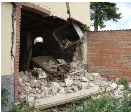
Figura 2-27: Aggregato 4903565. Ribaltamento di parete con intonaco armato in fase di esecuzione
