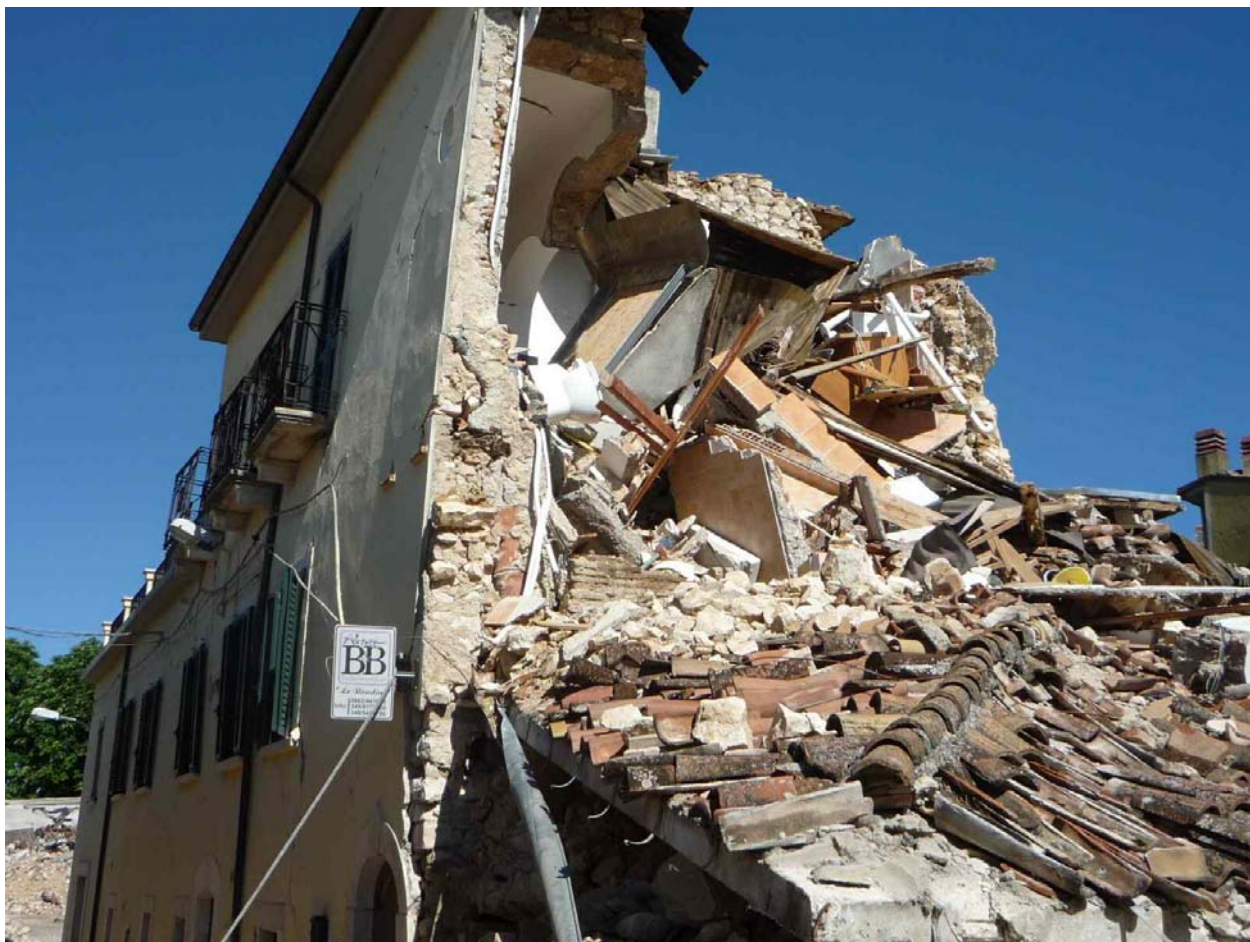
9 - Presso flessione fuori piano di una tesa muraria di tre livelli. Notare la spaccatura a metà circa (cerniera orizzontale intermedia del meccanismo di presso flessione) in corrispondenza di un indebolimento della sezione muraria.
