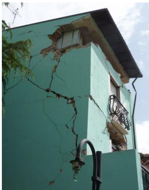
Figura 4902745-22: U.S. 15, spigolo Sud-Ovest. Meccanismo di espulsione della parete Sud nella sua parte più alta. Lesione da ribaltamento di un ampio cuneo di muratura coinvolgente i piani 2 e 3. Si nota bene il movimento rotatorio della parete al terzo livello che risulta avere maggiori dislocazioni sullo spigolo Sud-Ovest che sullo spigolo Sud-Est.
