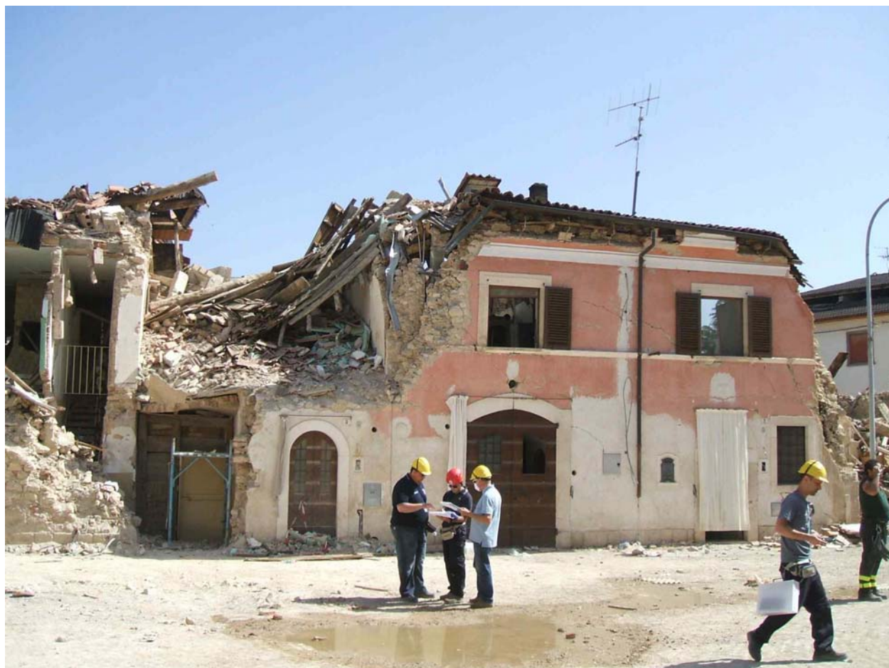
24 - Lesione di taglio al piano terra ed al primo livello del maschio murario centrale dell'edificio con intonaco rosa.
