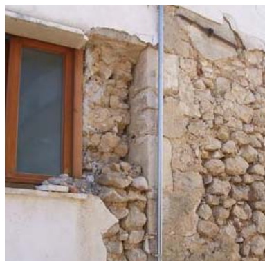
Figura 2-24: Angolata in blocchi squadrati annegata nella muratura di scarsa qualità.
