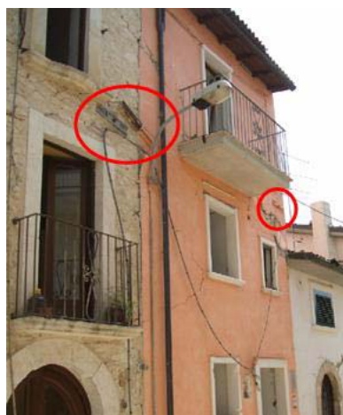
Figura 4902682-12: Capochiave in acciaio in direzione trasversale rispetto all'asse della schiera. Da sinistra si vedono: le U.S. 11, 13 e la 14 (a due piani). L'U.S. 11 ha il paramento murario stilato di recente.
