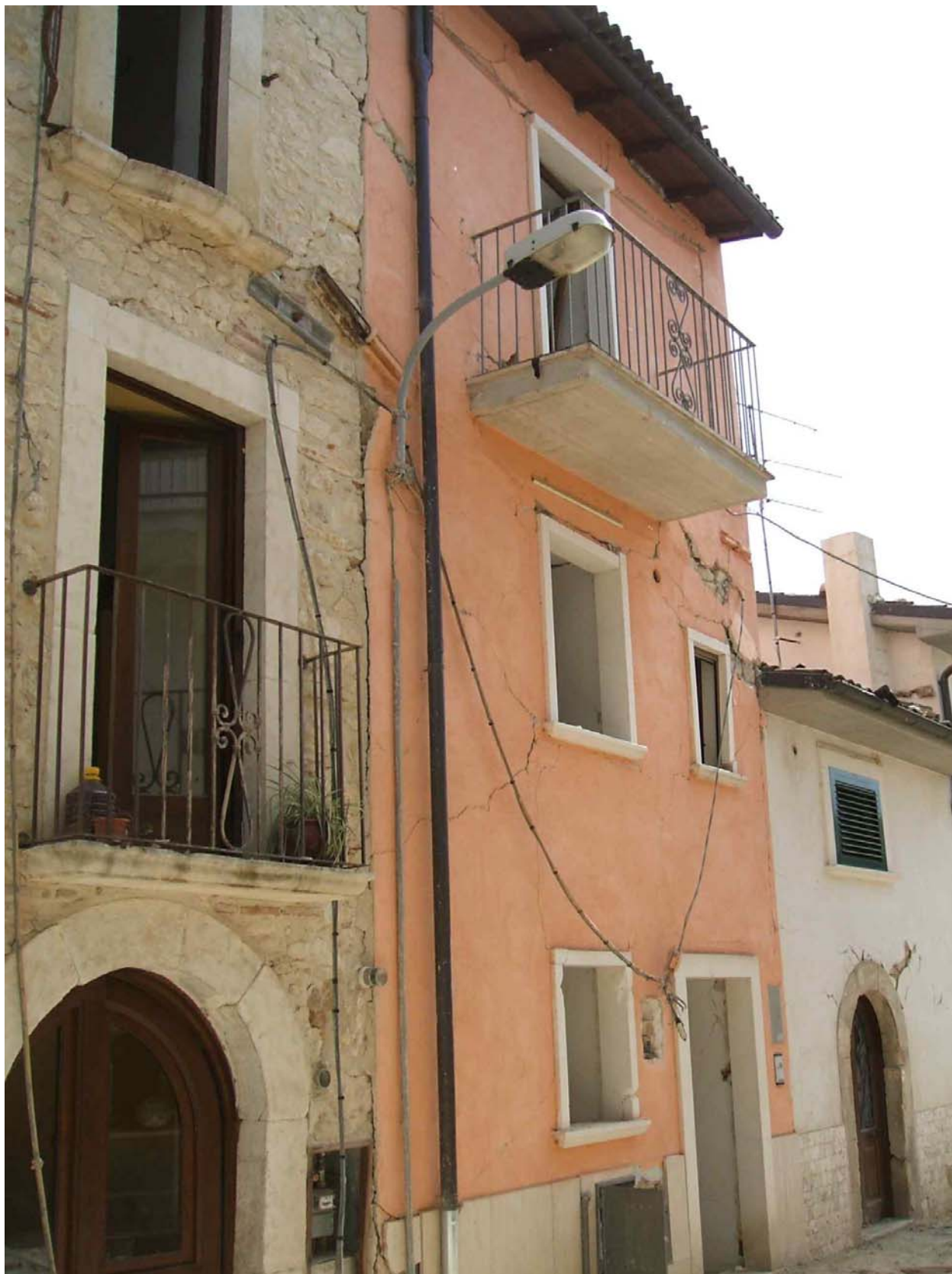
14 - Lesioni nel piano degli edifici sulla sinistra. Martellamenti ed interazioni fra i due edifici di differente altezza.
