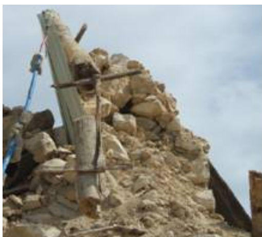
Figura 4902682-11: Antica catena in legno con estremità deteriorata e con capochiave in acciaio. Muratura circostante di scarsa qualità.
