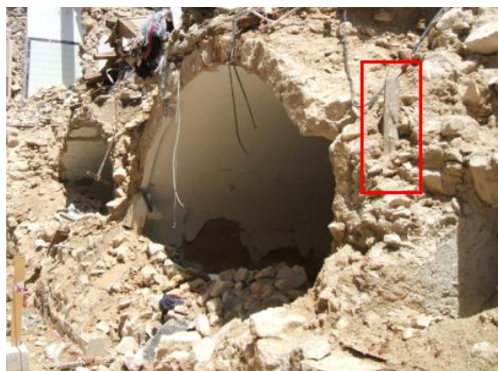
Figura 2-21: “Anima” verticale in legno emergente da un pannello murario crollato
