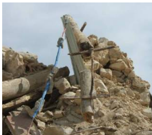
Figura 2-22: Catena in legno con capochiave in ferro
