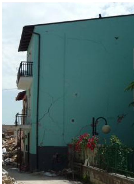
Figura 4902745-25: U.S. 15, spigolo Nord-Ovest e facciata Ovest. Il quadro fessurativo è meno accentuato ma congruente con il meccanismo di collasso ipotizzato.
