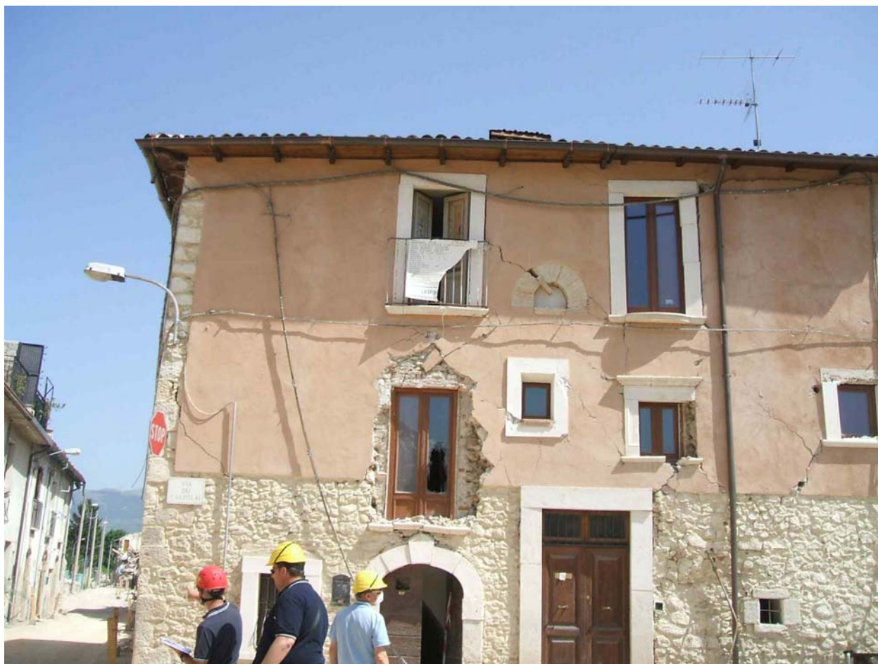
8 - Meccanismo di piano con lesioni sulla facciata dell'edificio in primo piano e scorrimento di un mattone nell'archetto al terzo livello. L'intero quadro fessurativo conferma un'ipotesi di movimento della facciata da destra verso sinistra: le lesioni di taglio monodirezionali sui maschi murari e le dislocazioni delle cornici bianche delle finestre.
