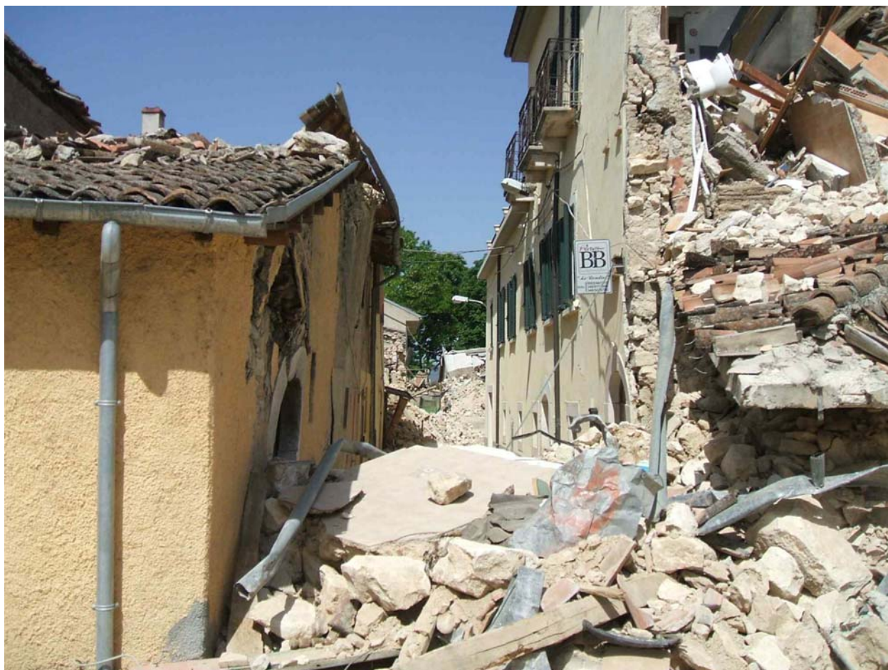
10 - Ribaltamento fuori piano delle pareti degli edifici a sinistra.
