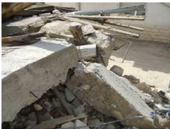
Figura 4902682-10: Cordolo di copertura dell'U.S. 2. Si noti la trave in legno che entra nell'angolo del cordolo.
