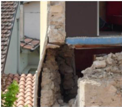
Figura 4902745-13: U.S. 11: assenza di collegamento fra il solaio di acciaio e la muratura sottostante. È da notare che la parete soprastante è di nuova edificazione.
