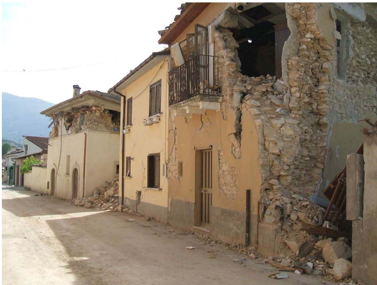
21 - Meccanismi nel piano sugli edifici a destra nella foto.
