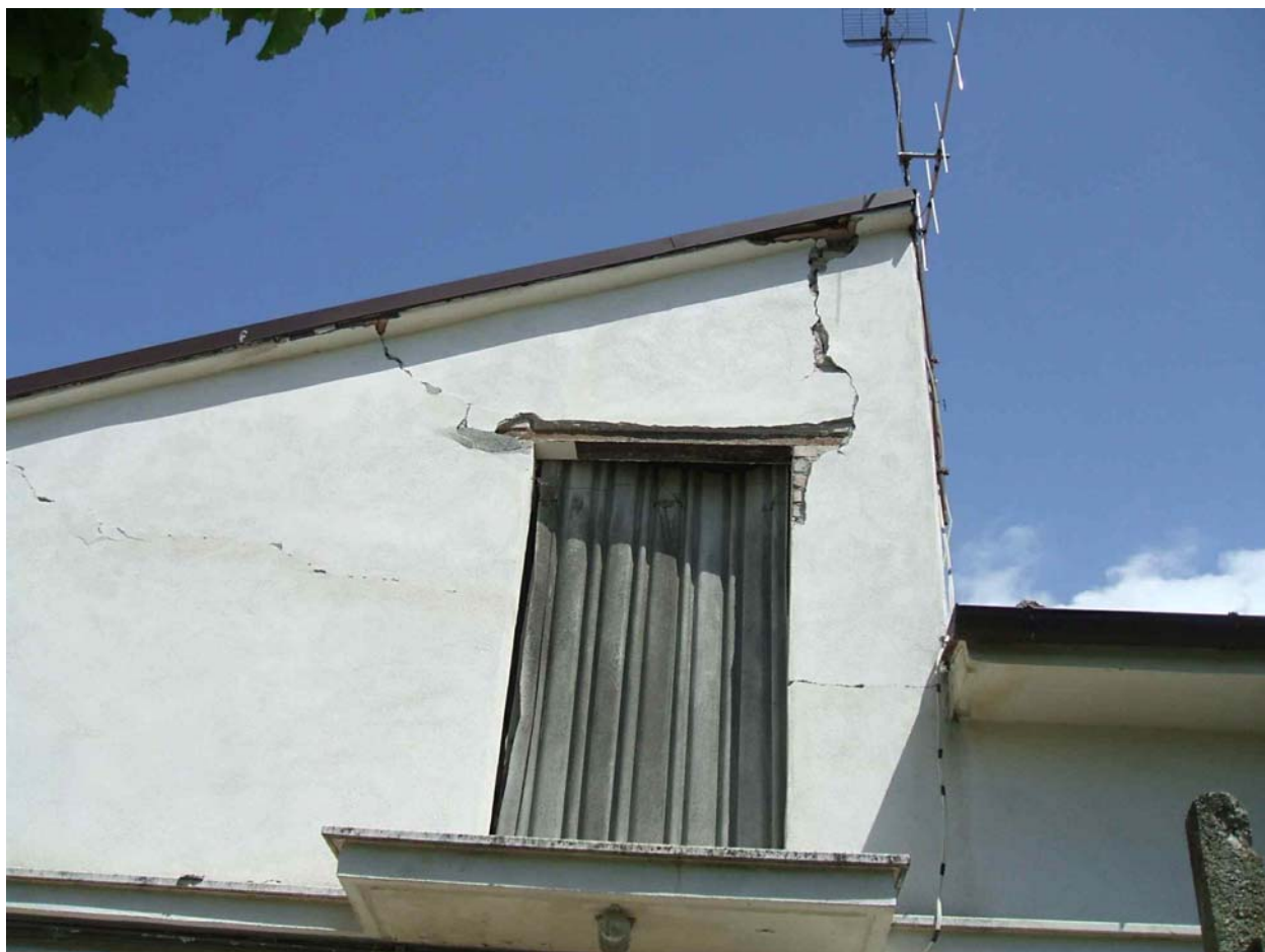
16 - Meccanismo nel piano del “torrino”; si può osservare anche su un altro torrino vicino. Il pilastro snello si lesiona per flessione, il maschio tozzo per scorrimento/taglio.
