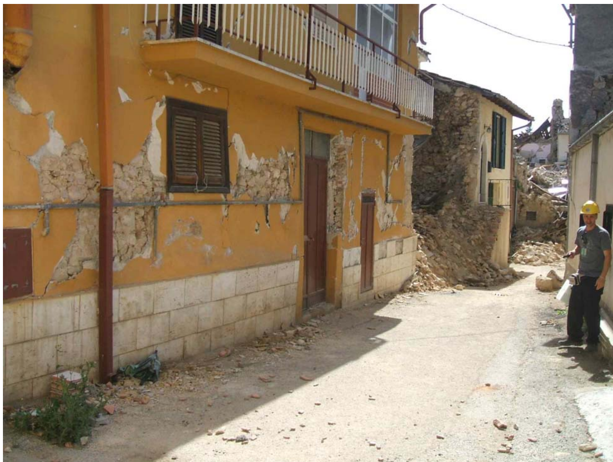
6 - Presso flessione verticale fuori piano del piano terra dell'edificio giallo sulla sinistra. Il primo maschio murario sulla sinistra sembra presentare anche lievi segni di taglio, tuttavia il fenomeno fessurativo prevalente in assoluto è il grande fuoripiombo di tutte le pareti del piano terra. Segnali visibili dalla foto sono: le deformazioni permanenti sulle spallette della porta e la separazione dei paramenti murari visibile sulla spalletta destra della porta.
