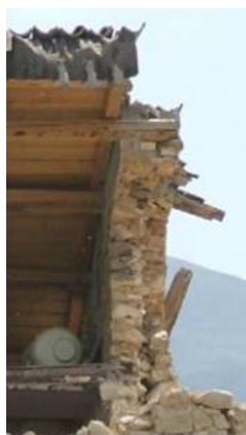
Figura 4902682-7: La muratura della U.S. 2 dell'aggregato al piano terra, lato via degli Oppieti. Si riportano il paramento esterno e la sezione muraria.
