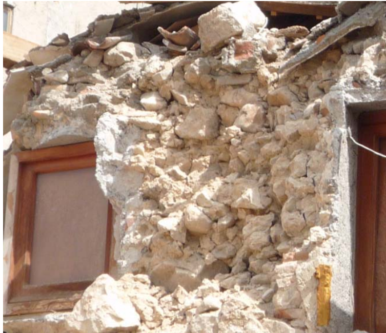
Figura 4902745-10: Sezione muraria e paramento della U.S. 4, parete prospettante sul cortile interno posta al primo livello. Il crollo del paramento esterno di tale maschio murario permette di osservare l'assenza di elementi di ingranamento trasversale nella parete, la disposizione caotica interna delle pietre e la povertà della malta.
