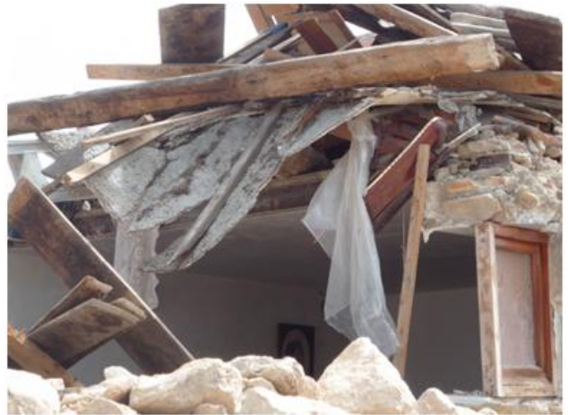
Figura 4902745-12: U.S. 4: copertura in legno e solaio sottostante in acciaio e tavelloni.
