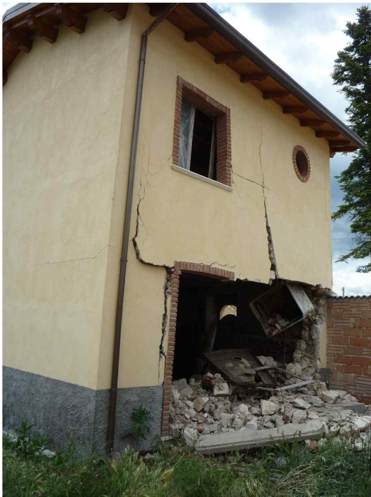
23 - Parete con intonaco armato in fase di esecuzione che ha subito un meccanismo fuori piano. Ciò appare desumibile dalla posizione delle macerie e della fascia superiore di intonaco armato, ancora dislocata nella direzione del collasso della parete sottostante. I due fogli di intonaco armato, quello superiore e quello inferiore, erano ancora totalmente scollegati.
