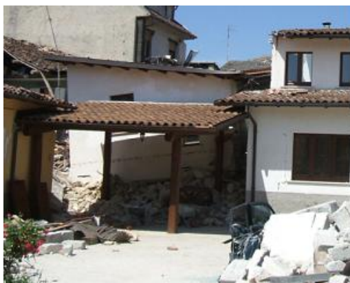
Figura 2-32: Edificio 4902644. Piano terra in pietra- me è crollato trascinandosi dietro, come blocco rigi- do, il primo piano in blocchetti.
