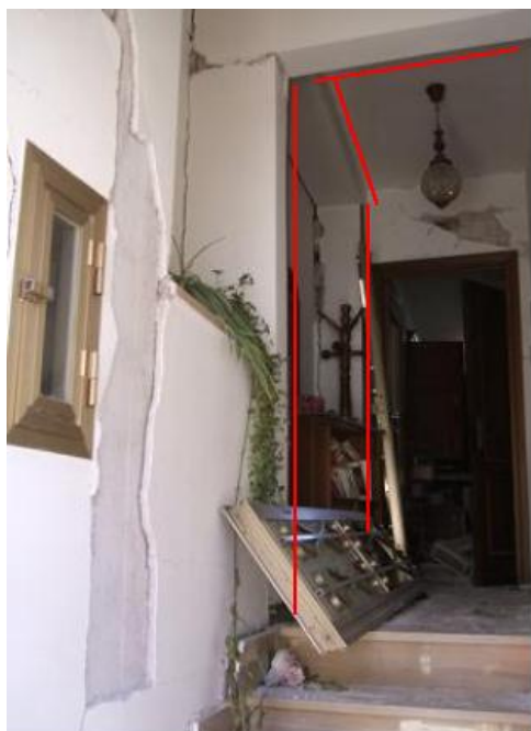
Figura 2-26: Aggregato 4902683. Evidenziate in rosso le membrature del telaio in c.a. arretrato rispetto al filo della muratura.
