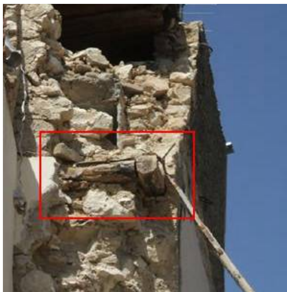
Figura 2-19: Angolo di cordolo in legno.
