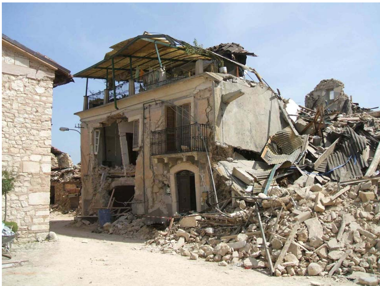
19 - Ribaltamento fuori piano della parete dell'edificio a destra, di fronte alla navata destra della chiesa. Sullo stesso edificio c'è una forte dislocazione in direzione ortogonale (meccanismo nel piano della facciata sulla piazza della chiesa) testimoniata da numerosi segnali: la spalletta sinistra della porta a piano terra, il tramezzo interno ruotato, lo spigolo sinistro dell'edificio con lesioni che lasciano intuire un movimento dell'intero secondo solaio dell'edificio verso sinistra.
