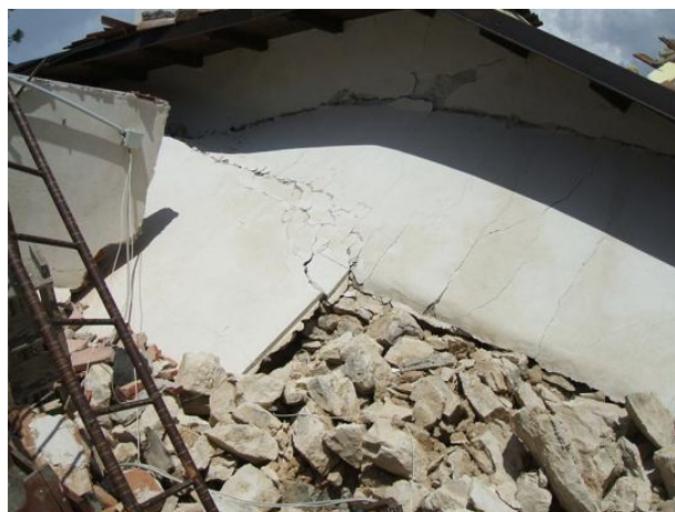
Figura 2-29: Intonaco armato eseguito solo parzialmente. Si tratta dell'aggregato 4902686 e l'intervento è stato eseguito nel 2007. Nella porzione in basso a destra della parete è stata lasciata la pietra a vista senza completare la fasciatura con la rete elettrosaldata e l'intonaco armato.
