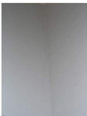
Figura 4902640-4902641-6: Lesione capillare interna su incrocio murario
