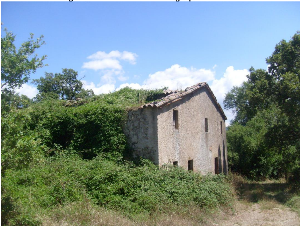
Figura 4 - Possibile edificio rifugio per i chiroterri
