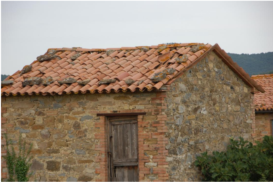
Figura 3 - Possibile edificio rifugio per i chiroterri
