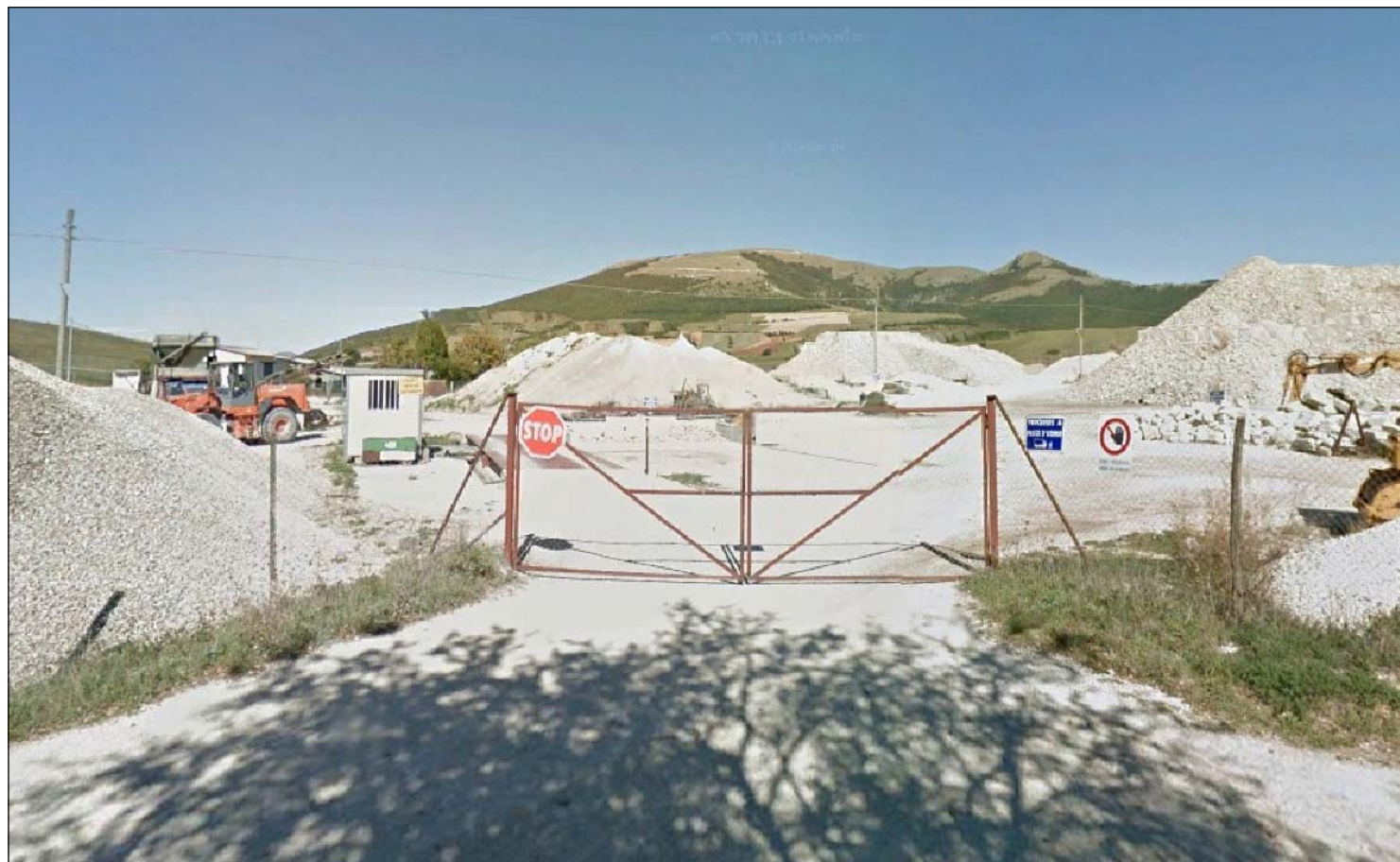
Punto di ripresa 8 - Vista da sud dell'accesso dell'area di intervento
