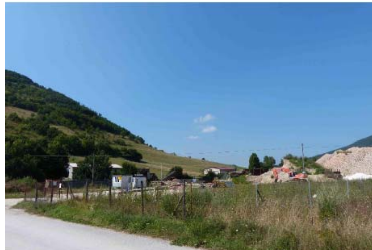
Accesso dell'impianto da sud-est.
