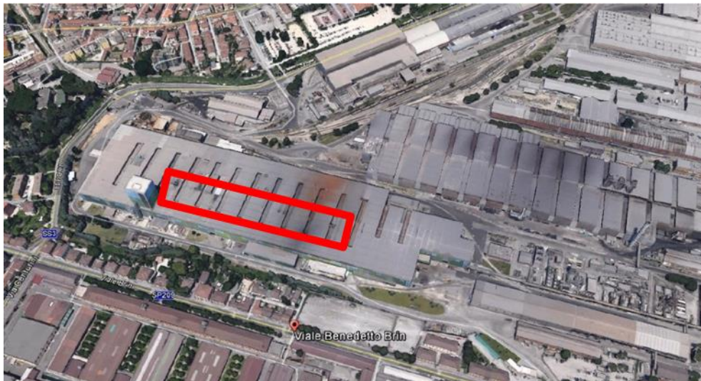
Figura 5 Dettaglio aereo del reparto PX2 lato sud
