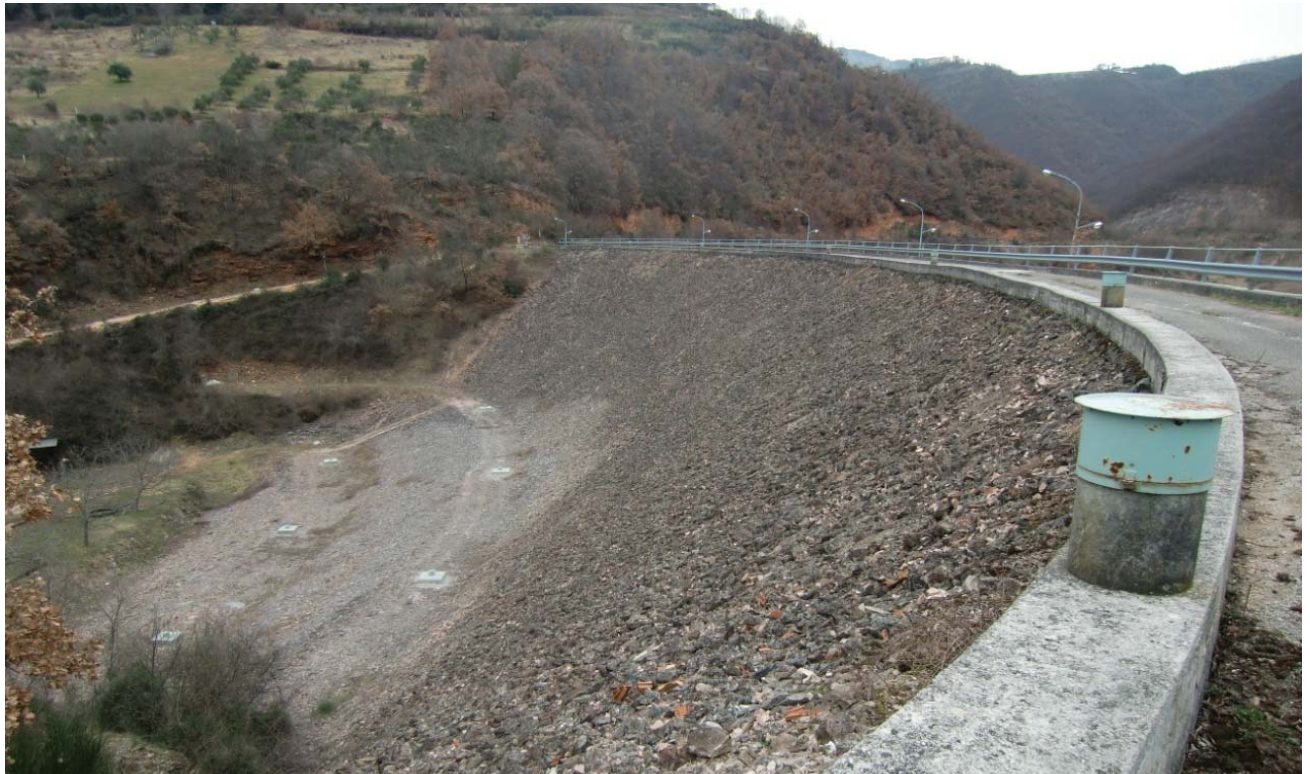
Figura 36 – Coronamento diga con capisaldi da rimuovere e riposizionare (quelli visibili sul paramento di valle verranno salvaguardati)
