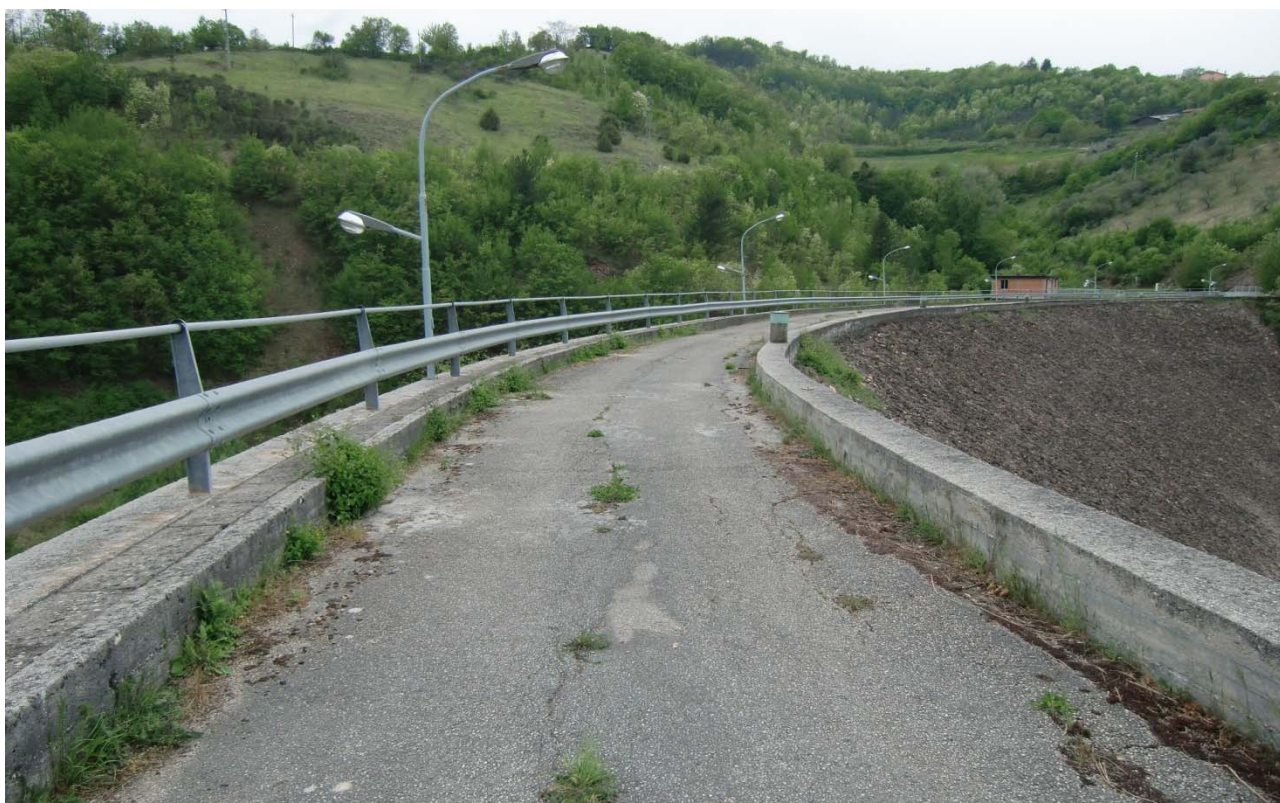
Figura 4 – Lesioni longitudinali attualmente presenti sul piano di coronamento della diga
