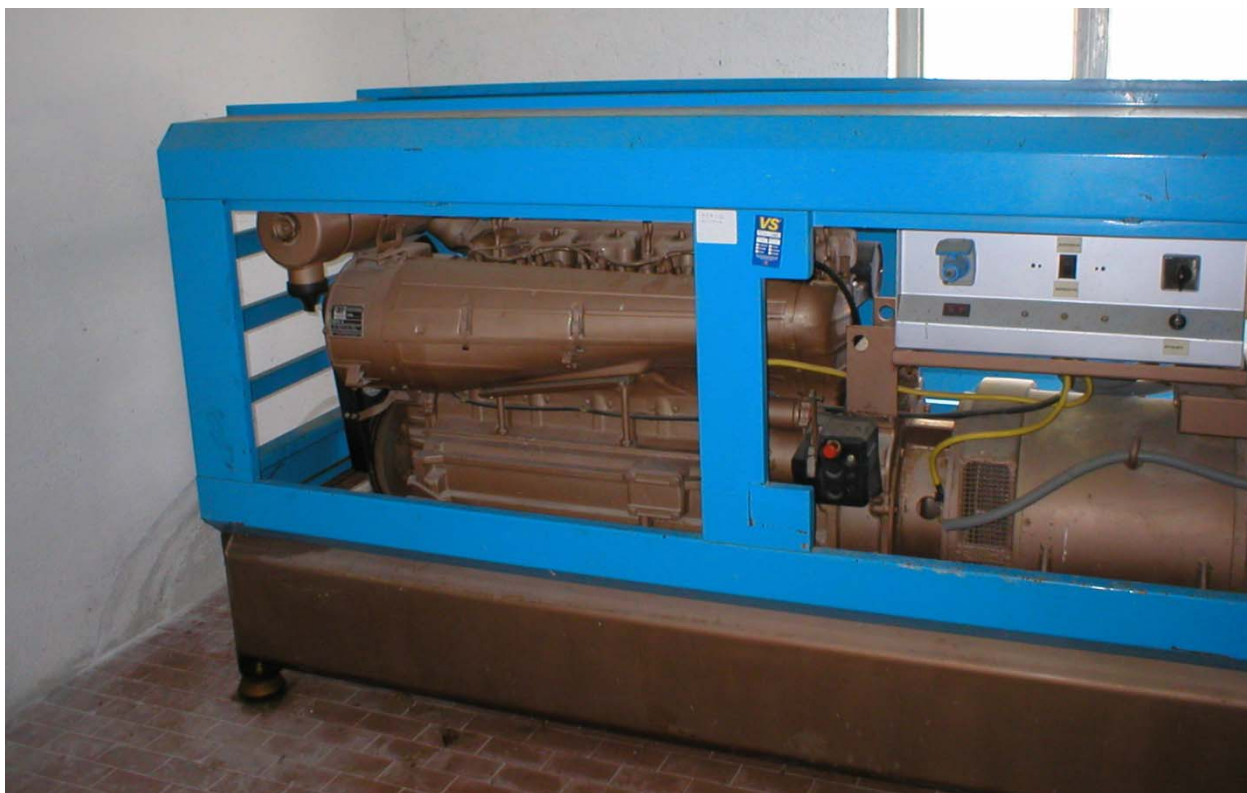
Figura 34 – Gruppo elettrogeno di emergenza ubicato nel relativo locale
