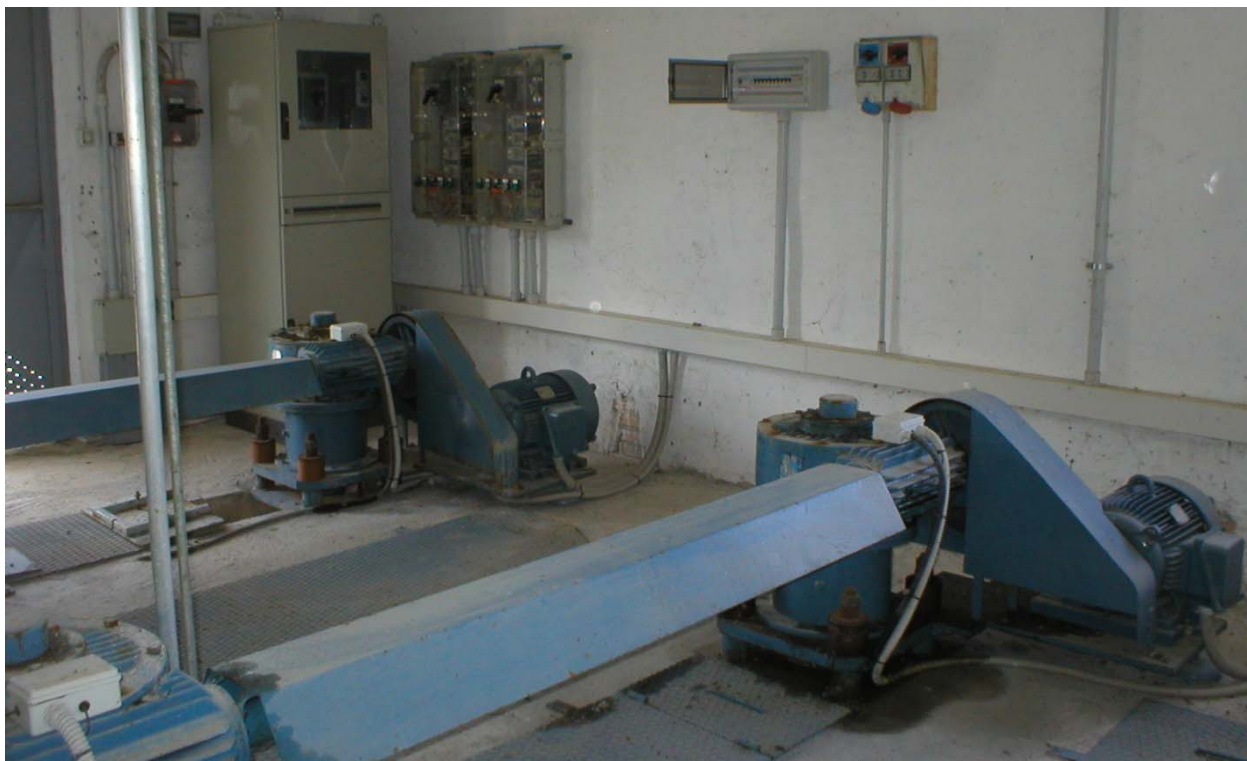
Figura 33 – Interno cabina di manovra con dispositivi di comando paratoie e quadri elettrici
