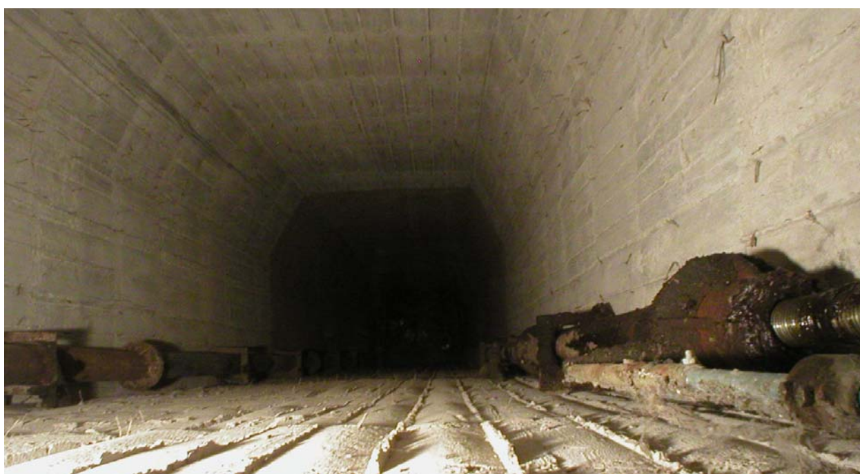
Figura 25 – Interno torre di manovra ove verrà installata la scala di accesso al locale di manovra: sono visibili le aste di comando della paratoia di valle
