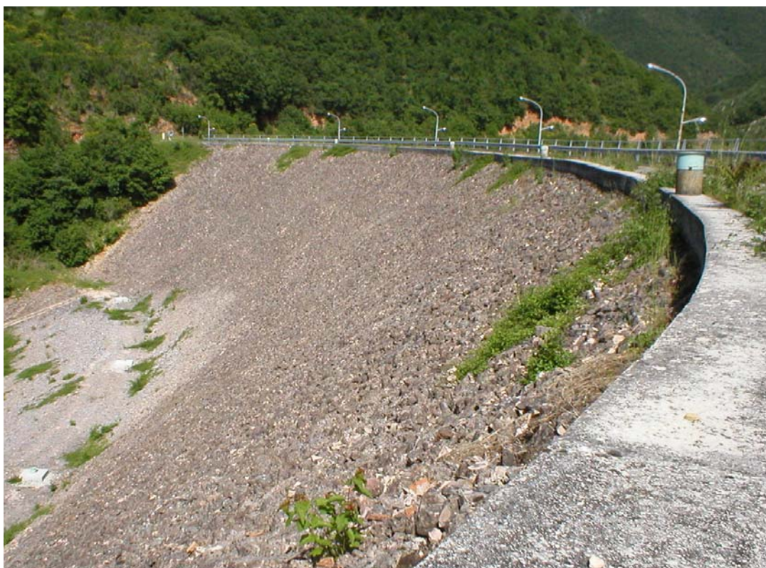
Figura 7 – Diga di Acciano: stato attuale del paramento di valle
