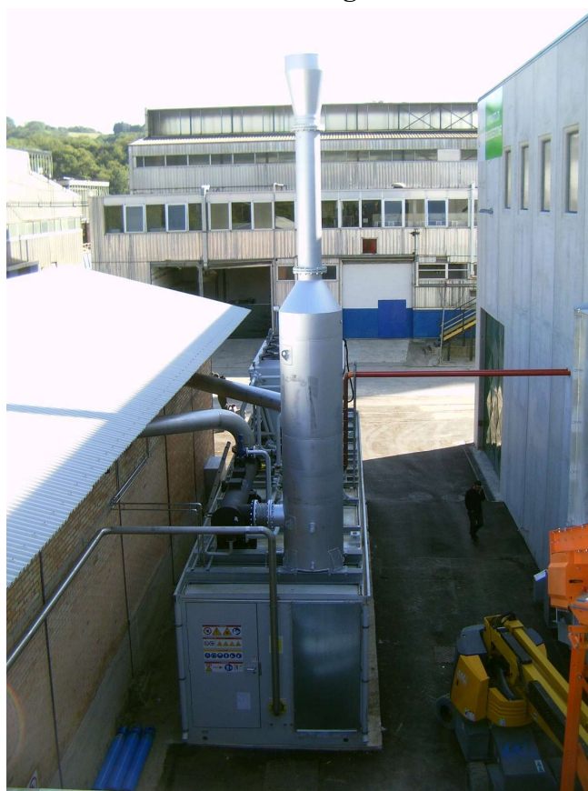
PV5- Unità di cogenerazione
