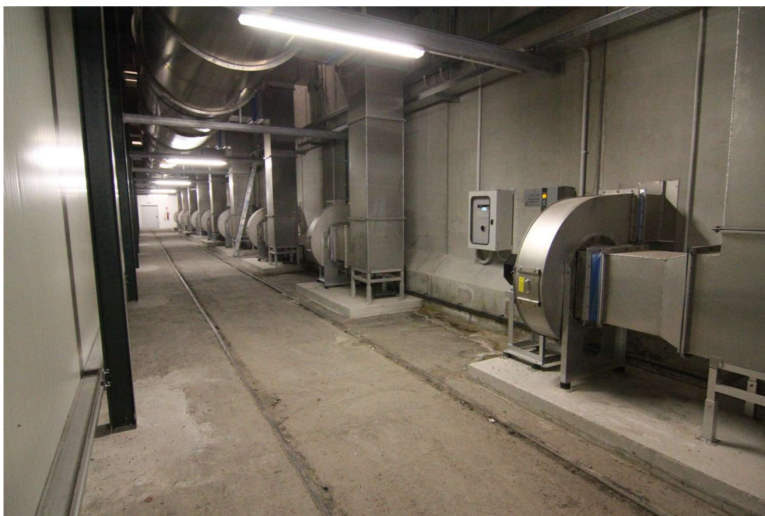
PV7– Ventilatori biocelle (interno capannone)
