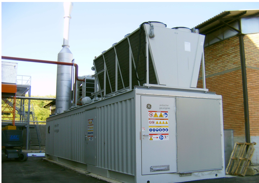
PV4- Unità di cogenerazione
