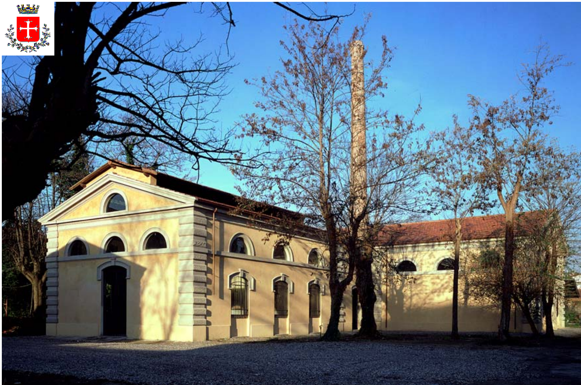
Area ex Macelli Pubblici. Vista esterna
