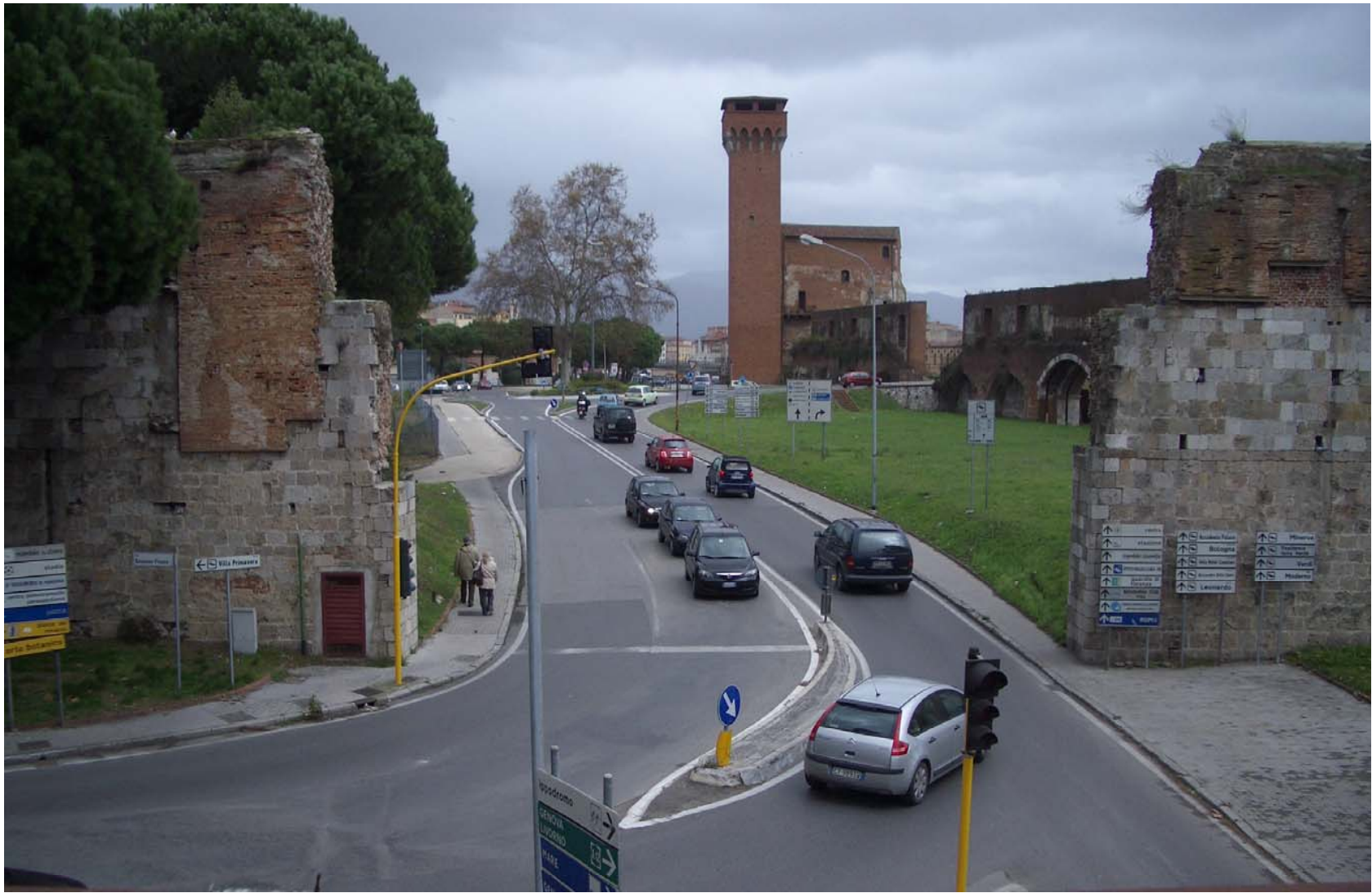
Veduta delle Mura occidentali dal ponte della ferrovia
