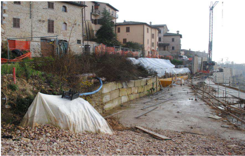
Figura 8 - Survey: UT 3 A e B coperti dai teli
