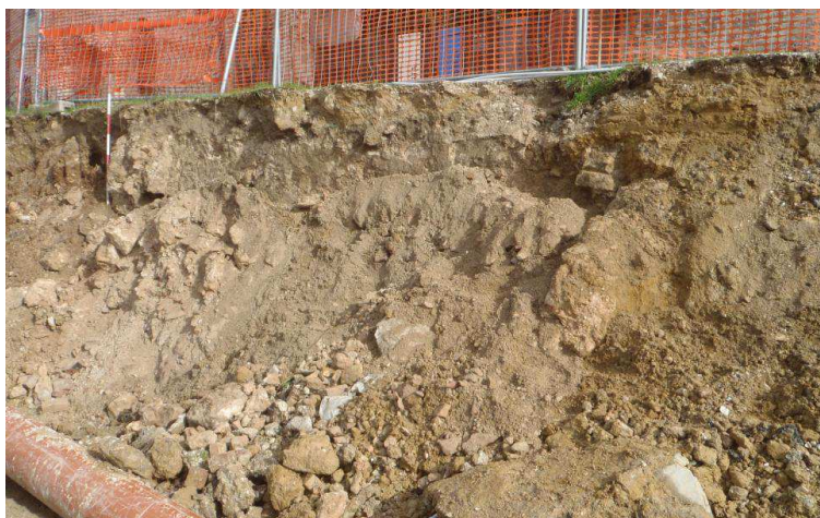
UT 3 B, le murature sono visibili poco sotto il piano stradale (foto Germini)
