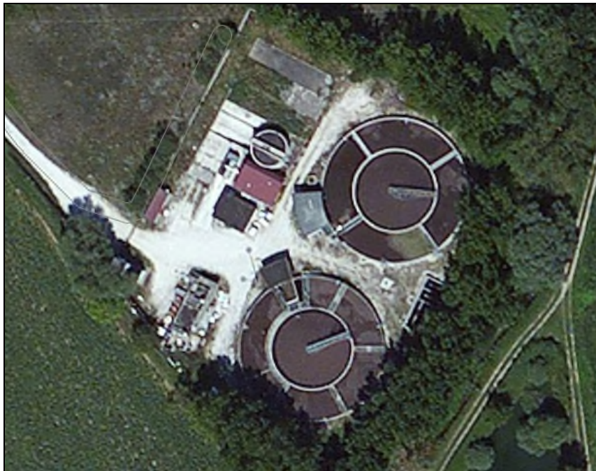
Figura 2: Vista aerea dell'impianto di depurazione di Sant'Erasmus – Gubbio.
