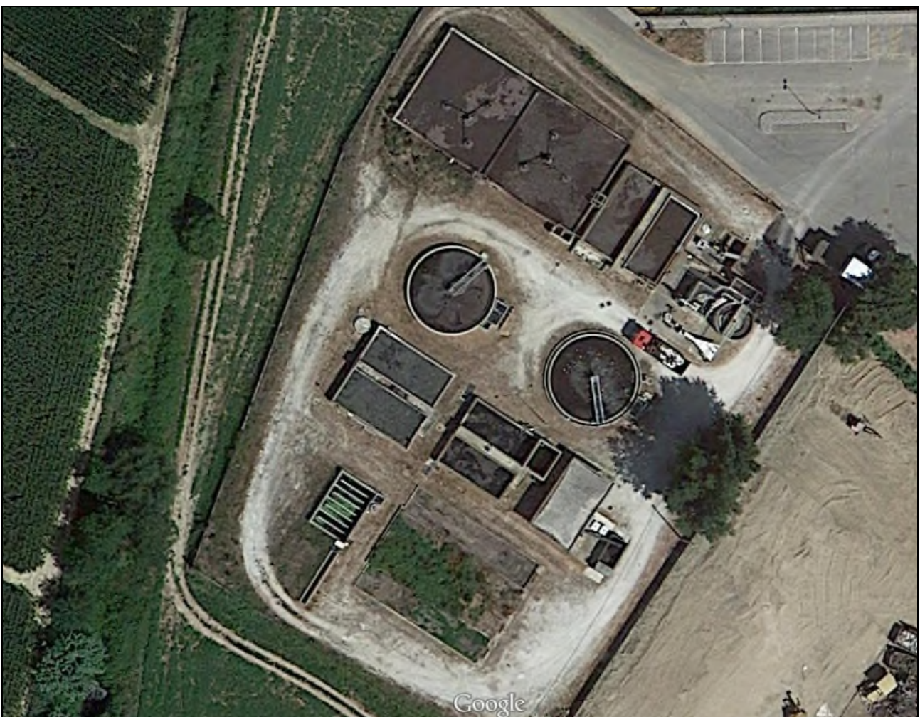
Figura 2: Vista aerea dell'impianto di depurazione di Deruta.
