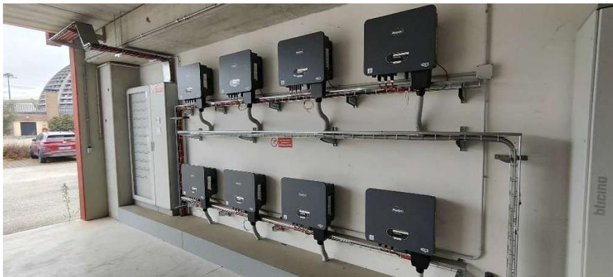
*Foto 208 – Autoparco (G) - Impianto Fotovoltaico Inverters*
