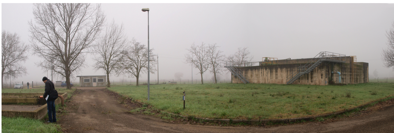
Foto 2. Vista all'interno dell'area
