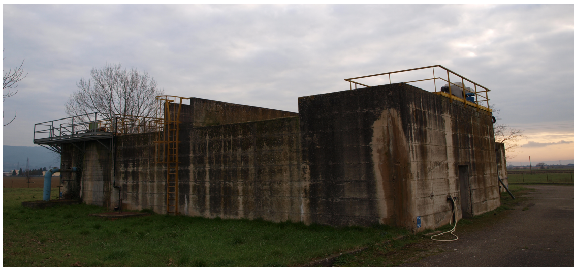
Foto 3. Vista della vasca dei trattamenti esistente
