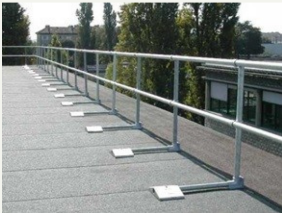
Copertura protetta con parapetti
