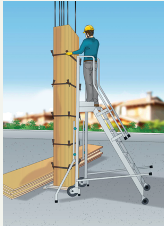
Esempio di scala mobile con piattaforma, ai sensi della UNI EN 131-7
