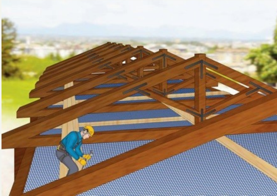
Operatore collegato a sistema anticaduta (linea vita, imbracatura, ecc.), predisposizione camminamenti con tavole e impiego di reti di sicurezza (Sistema S)
