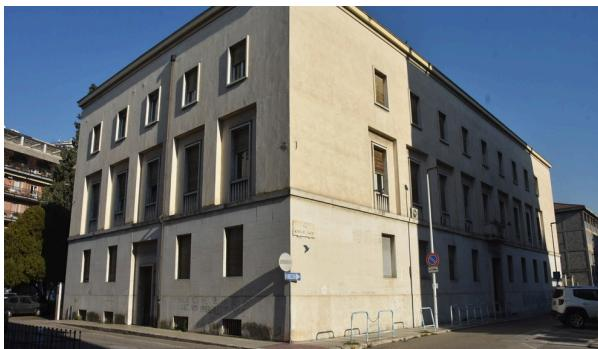
Gli interventi prevedono l'isolamento sismico dell'edificio, sede regionale di Via A. Saffi, 6 a Terni, attraverso l'inserimento di isolatori elastomerici, oltre a interventi per l'efficientamento energetico e la rifunzionalizzazione complessiva degli spazi interni.
