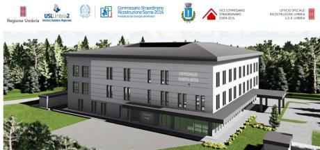
Il progetto esecutivo prevede la realizzazione di un edificio a pianta quadrata con corte centrale e copertura inclinata, per un totale di tre piani fuori terra di circa 1000 mq ognuno.
