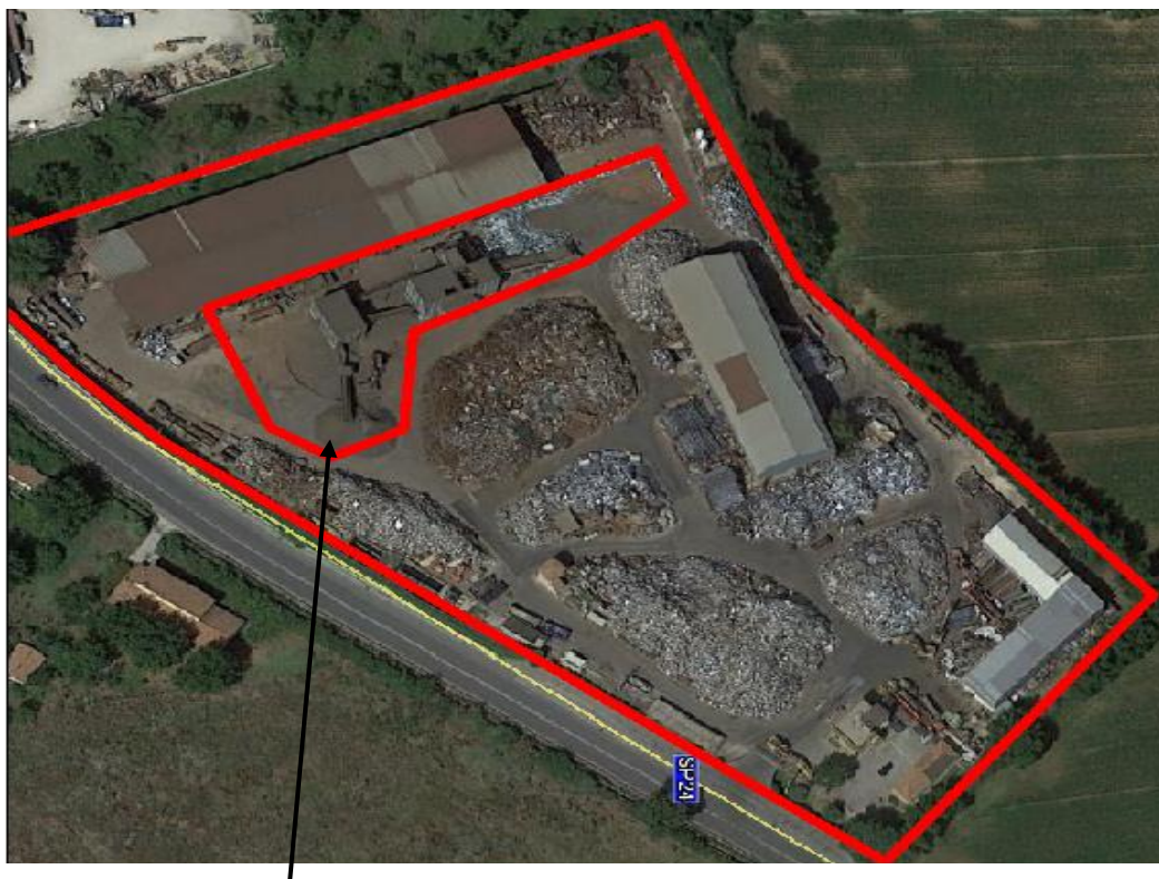
Foto aerea impianto Terni Frantumati S.p.a.
