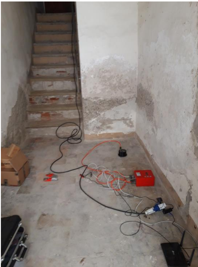
Stazione accelerometrica di Città di Castello
