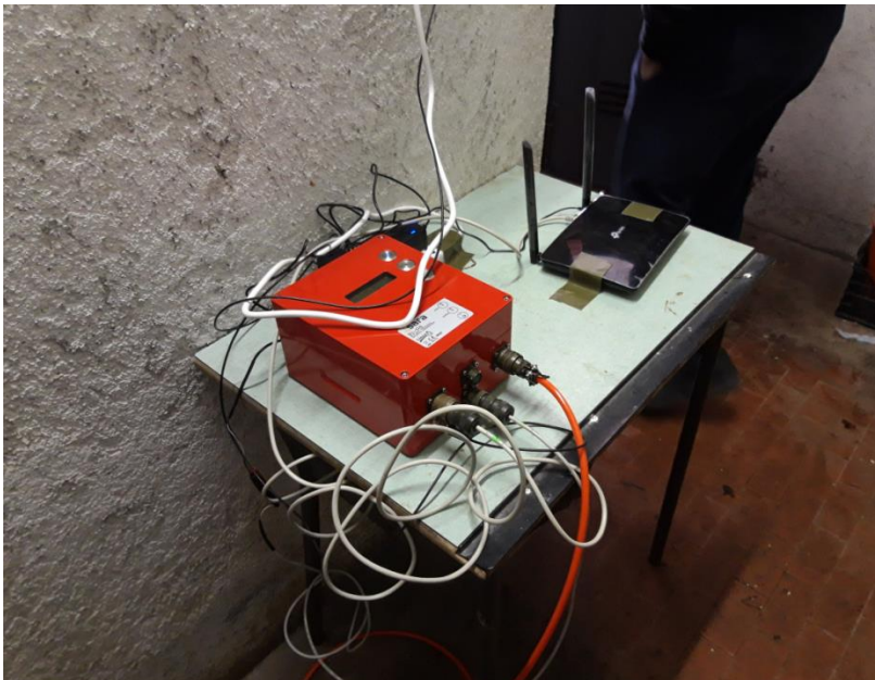
Stazione accelerometrica di Cascia
