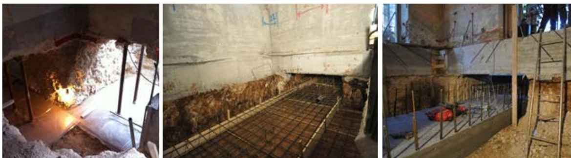
Vista della sottofondazione dell'edificio in muratura e della seconda fase di scavo e realizzazione dei baggioli di appoggio.
