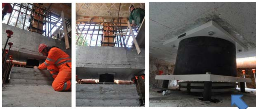
Fase di inserimento e fissaggio dell'isolatore, posa in opera del martinetto piatto a perdere al di sotto l'isolatore
