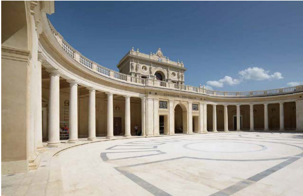
Palazzo dell'Emiciclo a L'Aquila sede del Consiglio Regionale dell'Abruzzo – adeguato sismicamente mediante l'isolamento alla base
