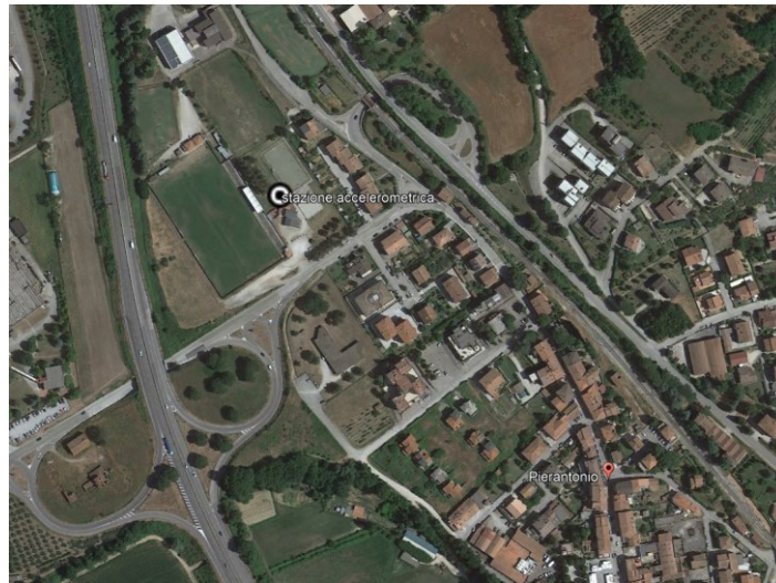
Localizzazione della stazione accelerometrica ReSiR (provvisoria) presso Pierantonio
