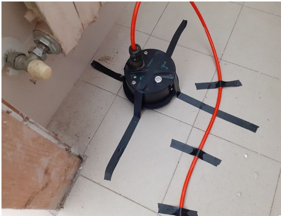
Stazione accelerometrica provvisoria ReSiR di Pierantonio, accelerometro Episensor FBA ES-T
