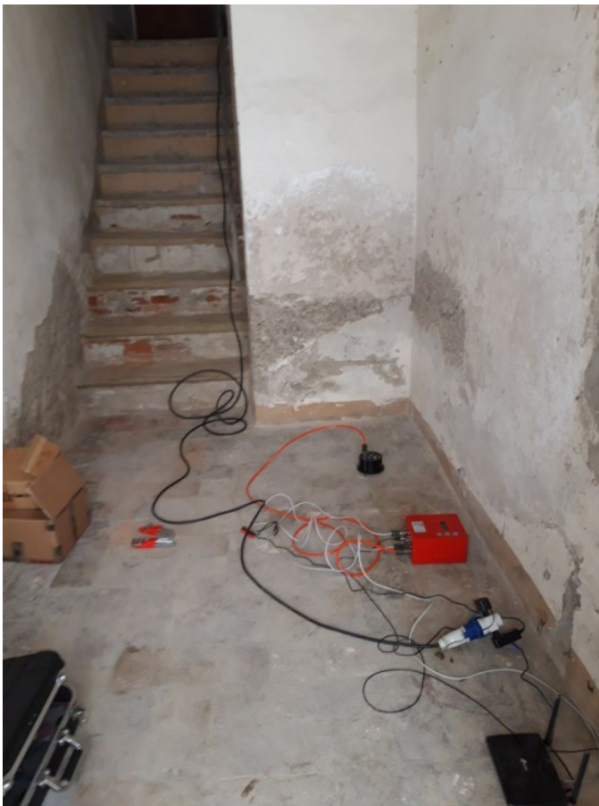
Stazione accelerometrica di Città di Castello
