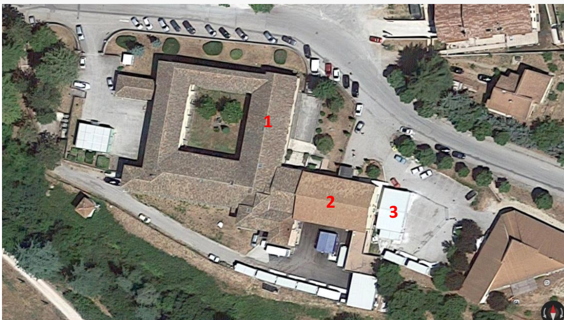
FIG. 1 .VISTA AEREA DELL'OSPEDALE DI NORCIA - 1 edificio storico 2 ampliamento 3 modulo prefabbricato
