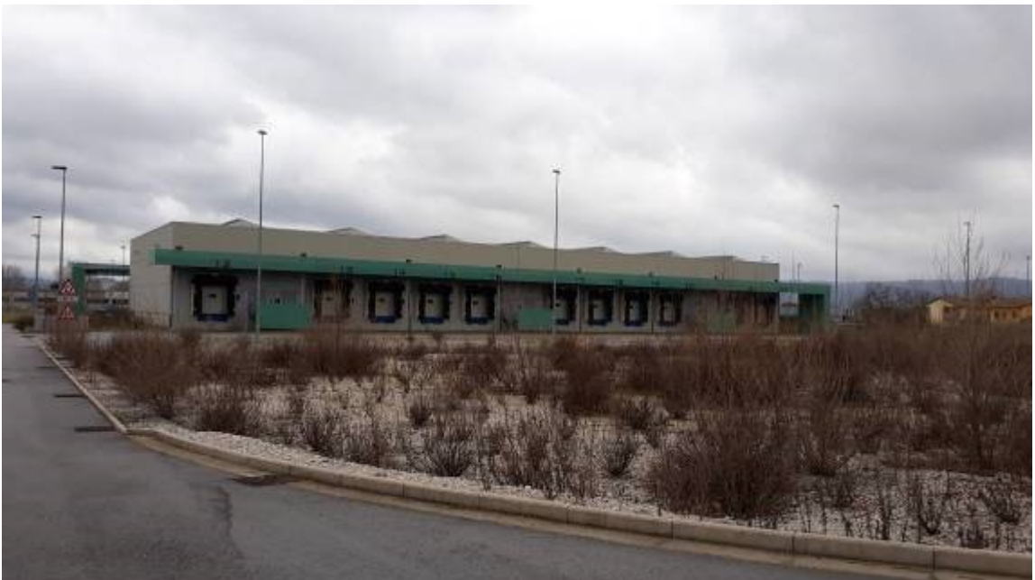
Magazzino Distribuzione lato Nord-Ovest e Area con potenziale edificatorio
