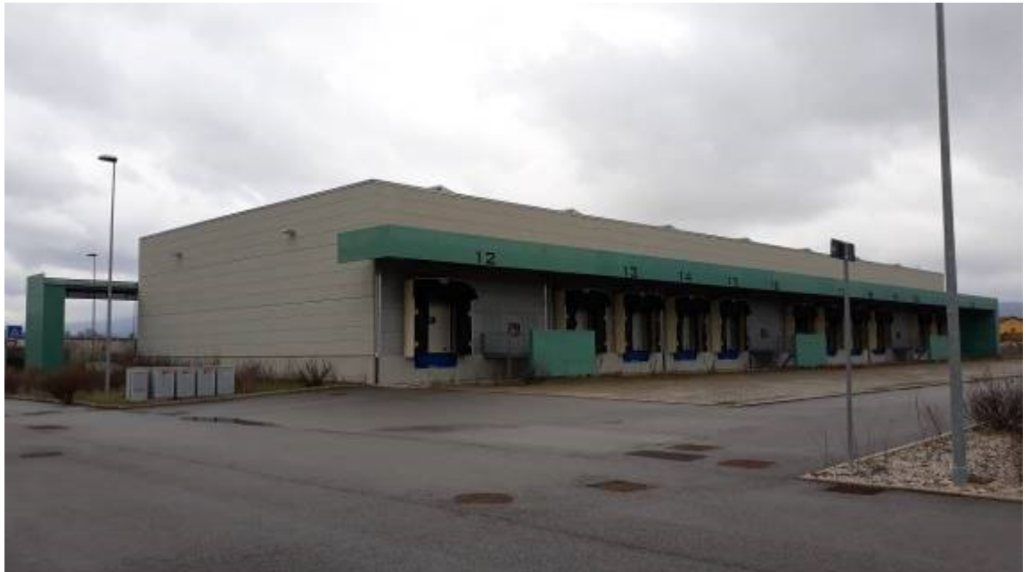
Magazzino Distribuzione – Lato Nord-Ovest
