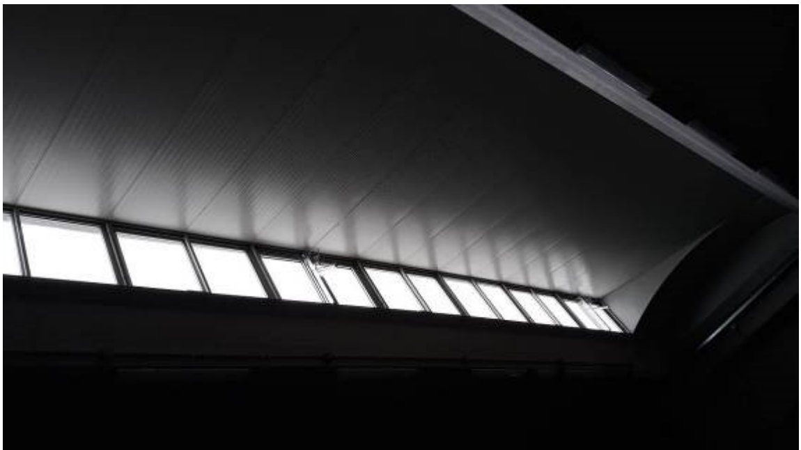
Magazzino Distribuzione – Particolare interno, copertura
