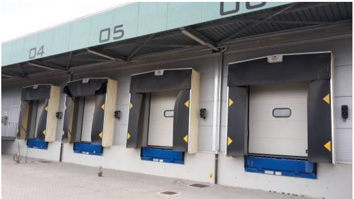
Magazzino Distribuzione – Lato Sud-Est – Particolare porte di carico con pedana mobile
