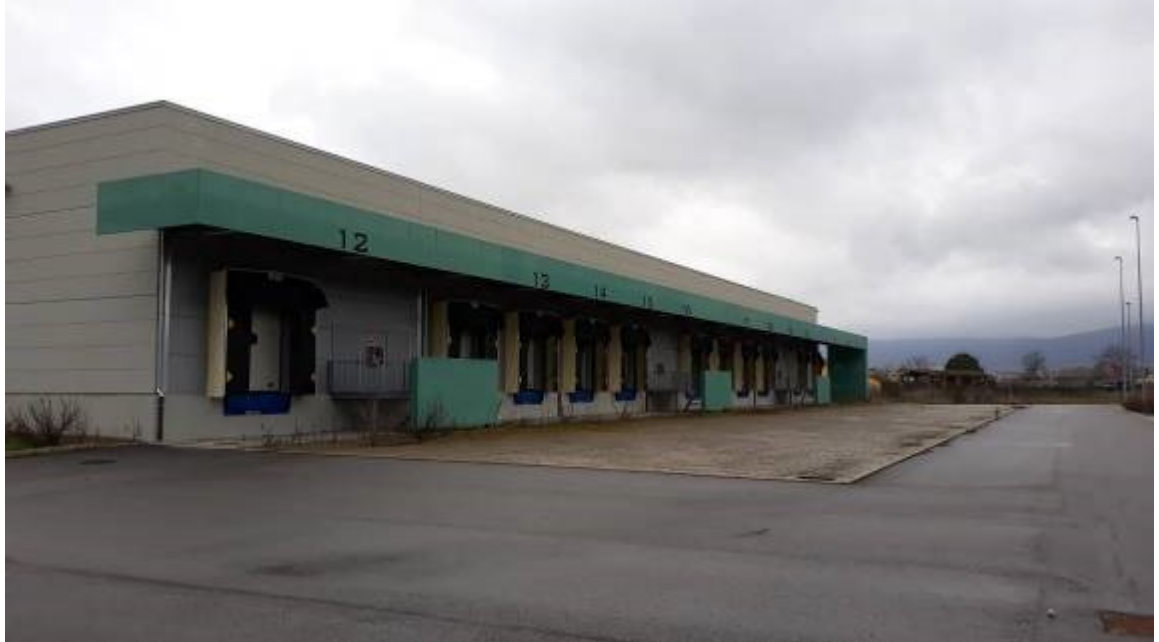
Magazzino Distribuzione – Lato Nord-Ovest
