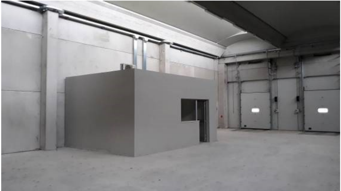
Magazzino Distribuzione – Particolare interno, locale di servizio
