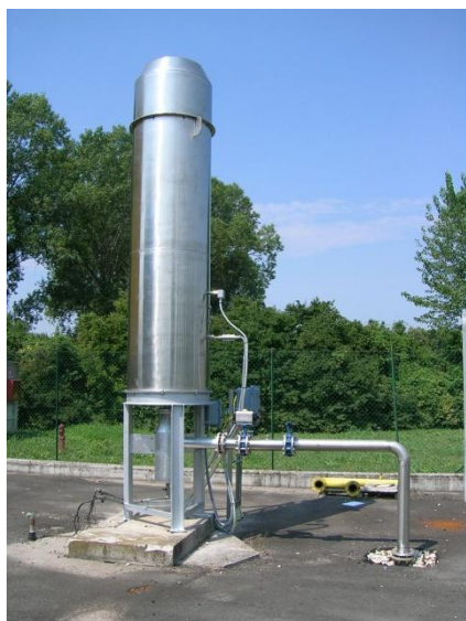
Figura 12: Esempio di torcia di combustione syngas
