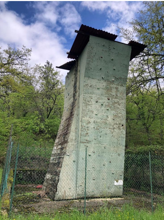
Foto 12 – area esterna, parete di arrampicata
