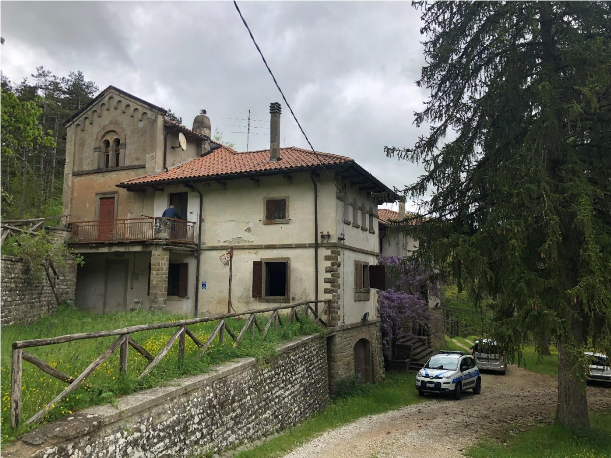
Foto 1 – ex villa padronale, vista esterna
