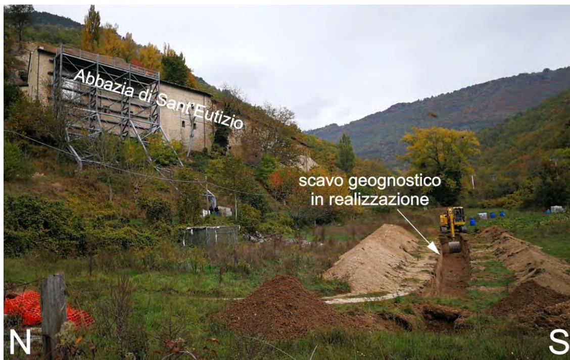
Fig. 6. Fase di esecuzione dello scavo geognostico realizzato nell'area adiacente (a Sud) all'Abbazia di Sant'Eutizio.
