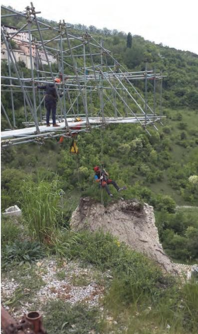
Calata dall'alto degli operatori incaricati della rimozione del pinnacolo di travertino.
