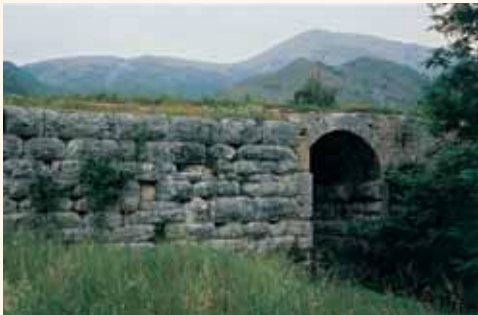
Ponte romano sulla via Flaminia (foto G. Tatge)
